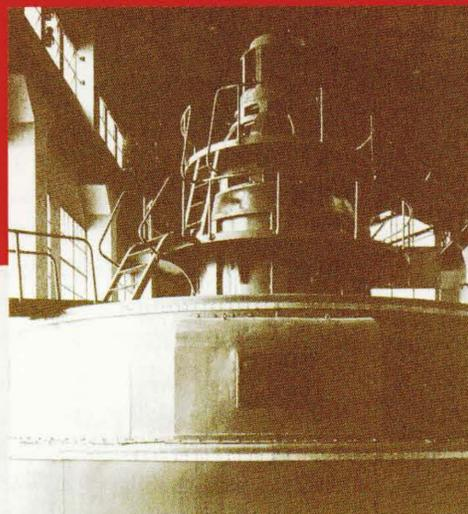
戦前の発展期において製作された鉄道省信濃川千手発電所納めの水車発電機。現在も稼働している。
