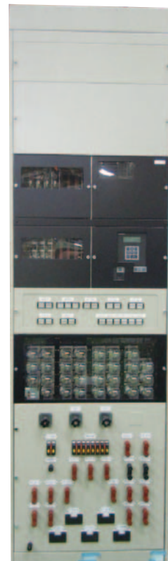
7 Veuxbusシリーズ適用500kV PCM電流差動保護リレー装置の外観
