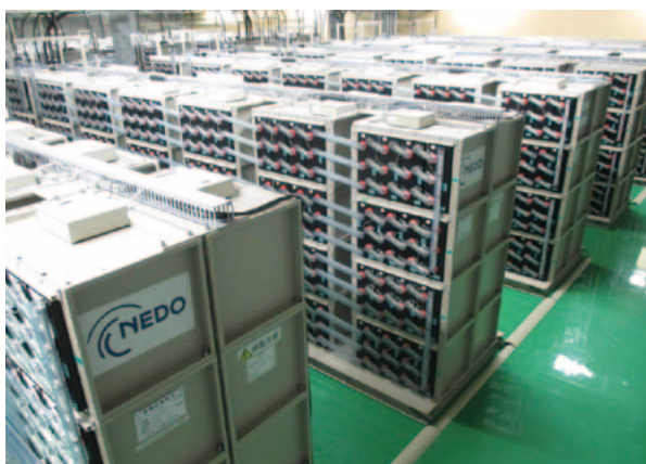
3 伊豆大島に設置された新型鉛蓄電池設備
