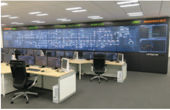
4 電力広域的運営推進機関システム運用センター
