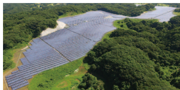
6 ゴルフコースの地形を生かした杭基礎による太陽電池パネルの配置
