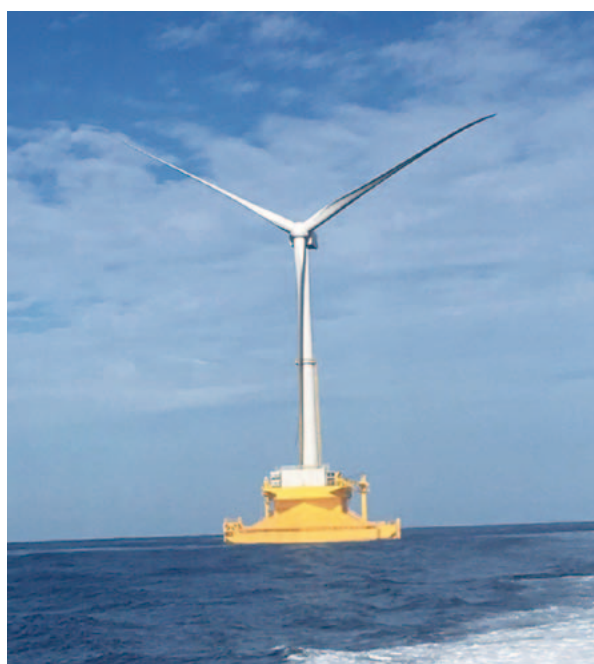
4 5 MWダウンウィンド型浮体式洋上風力発電設備（提供：福島洋上風力コンソーシアム）
