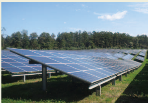
3 現地での杭載荷試験（上）、アレイ架台（下）
