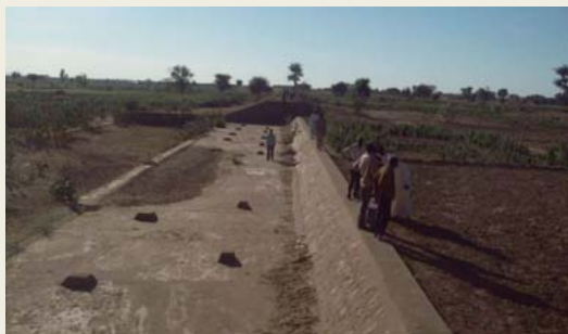
図2 | 破損し、放置されているスーダンのダム
