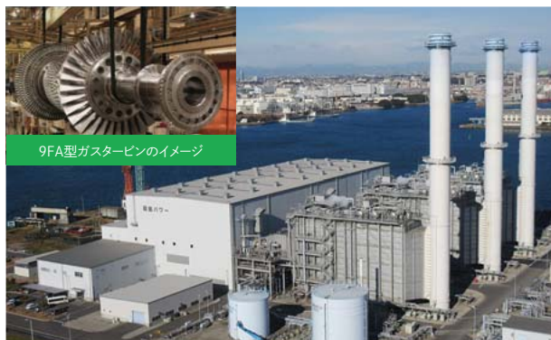
2 扇島パワーステーションAGP化改造工事
