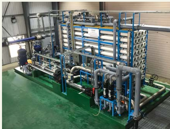
図1 | モルディブ共和国フルマーレ島に納入された海水淡水化設備
