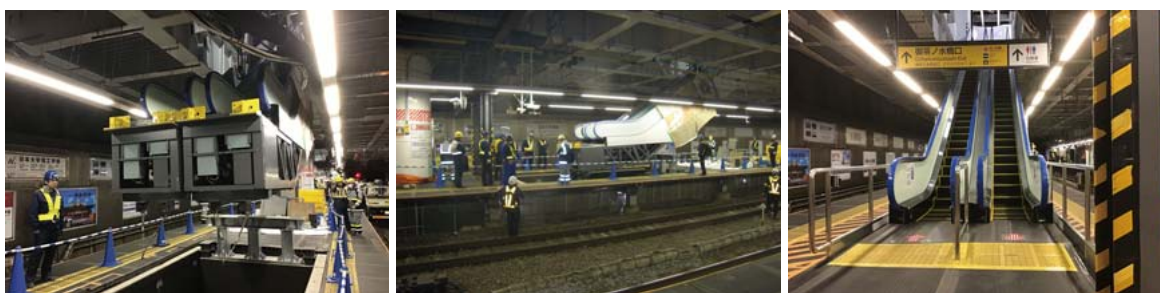
7 エスカレーター一体組品搬入（左）、（中央）、エスカレーター設置完了（右）
