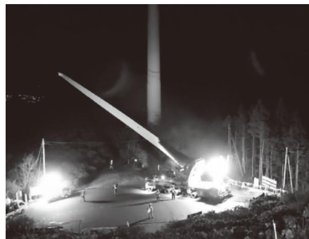
図3|ブレード起立台車輸送作業の様子
