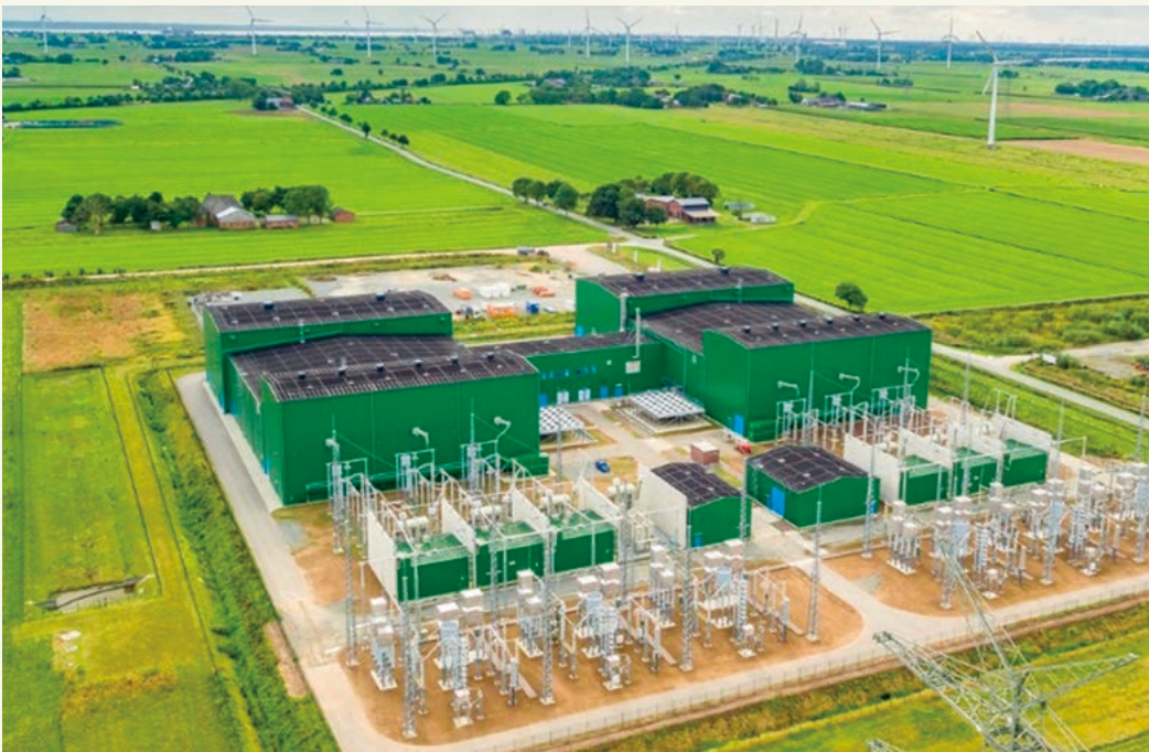
ノルウェー・ドイツ間の約600 km を直流で結ぶ±525 kV / 1,400 MWのHVDC「NordLink」
