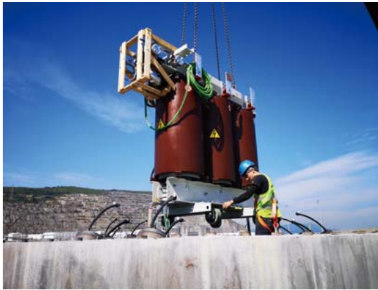
5 SaitecのタワーにCompactCoolユニットを設置する様子
