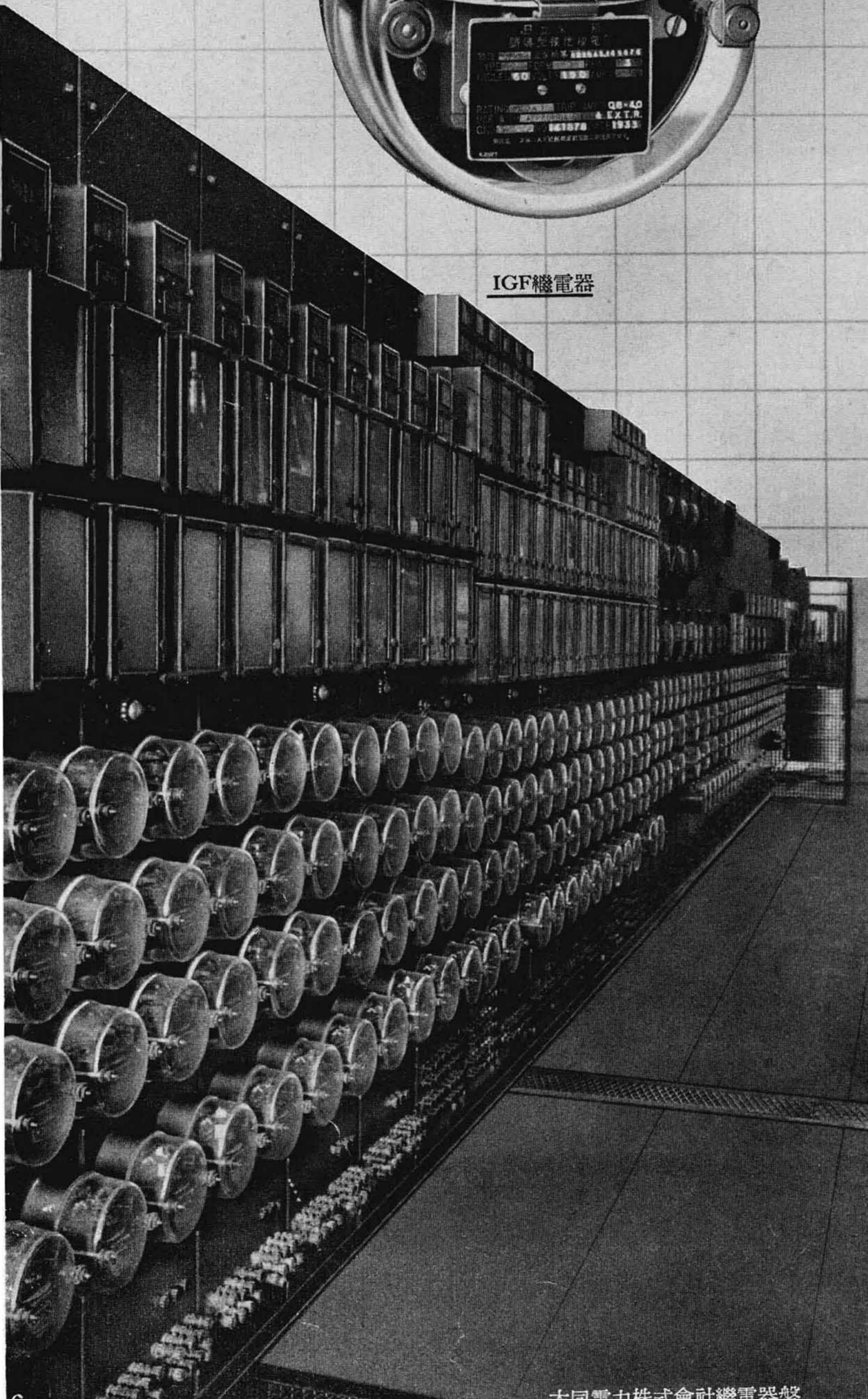
大同電力株式会社繼電器盤
