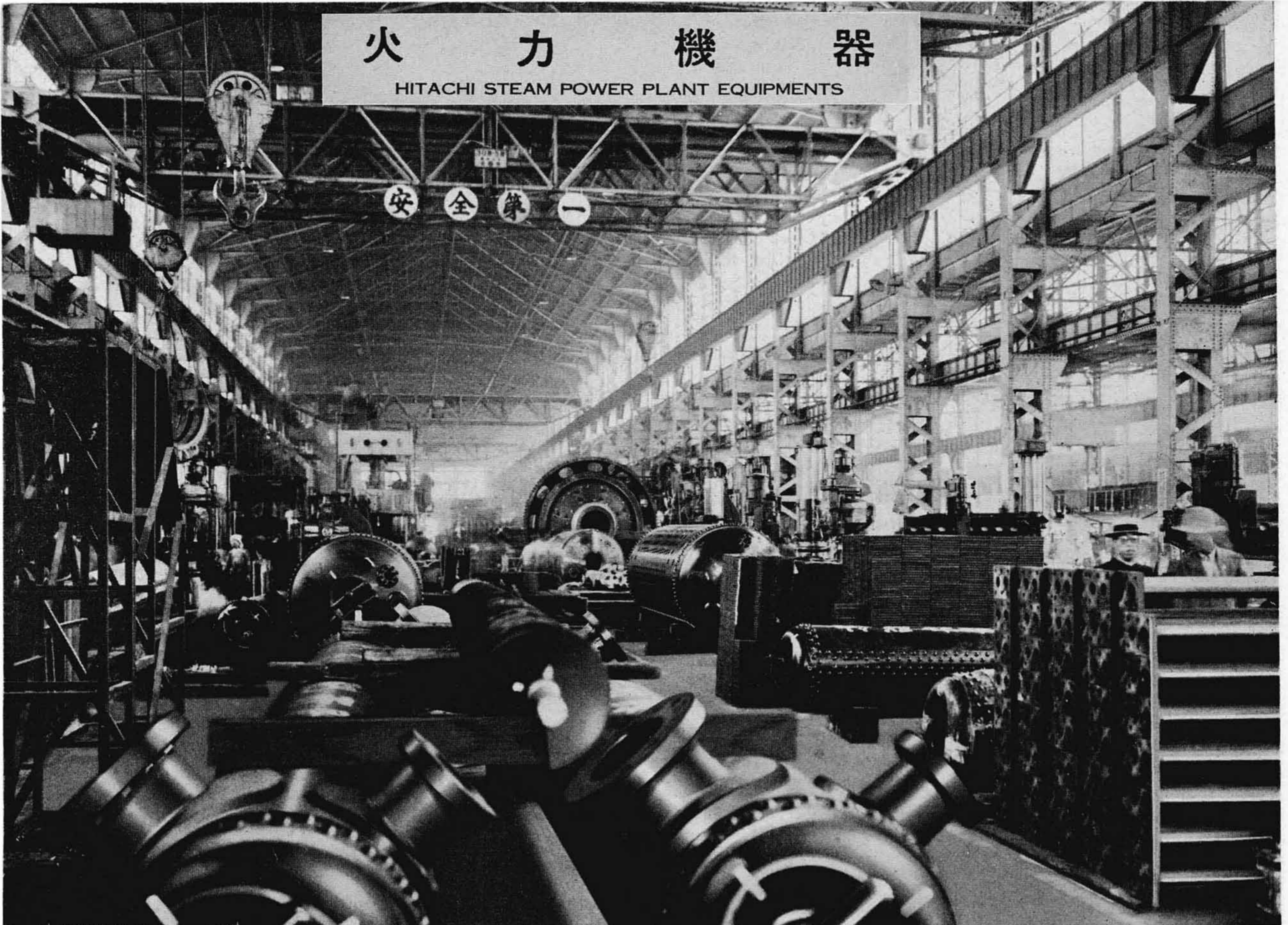
日立製作所ボイラー工場
