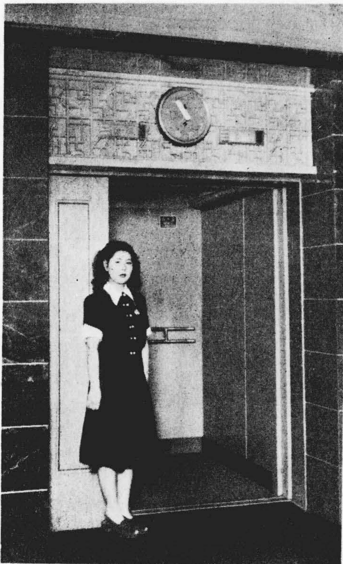
第1圖 白木屋納客用直流ギヤードエレベータ Fig. 1 D.C. Geared Traction Passenger Elevator Installed in Shirokiya.
