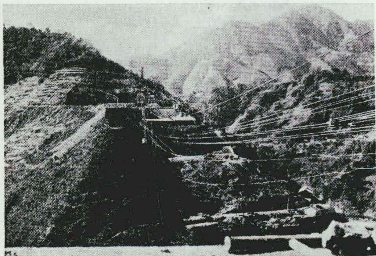
第 43 図 9 t ケーブル起重機(物部川永瀬ダム工事用) Fig. 43. 9 t Cable Crane for Construction of Nagase Dam
