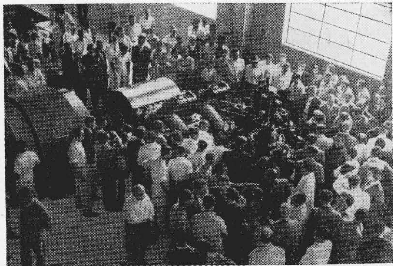
第5図 マカブ発電所の試運転実況 Fig. 5. Trial Running in Macabú P.S.
