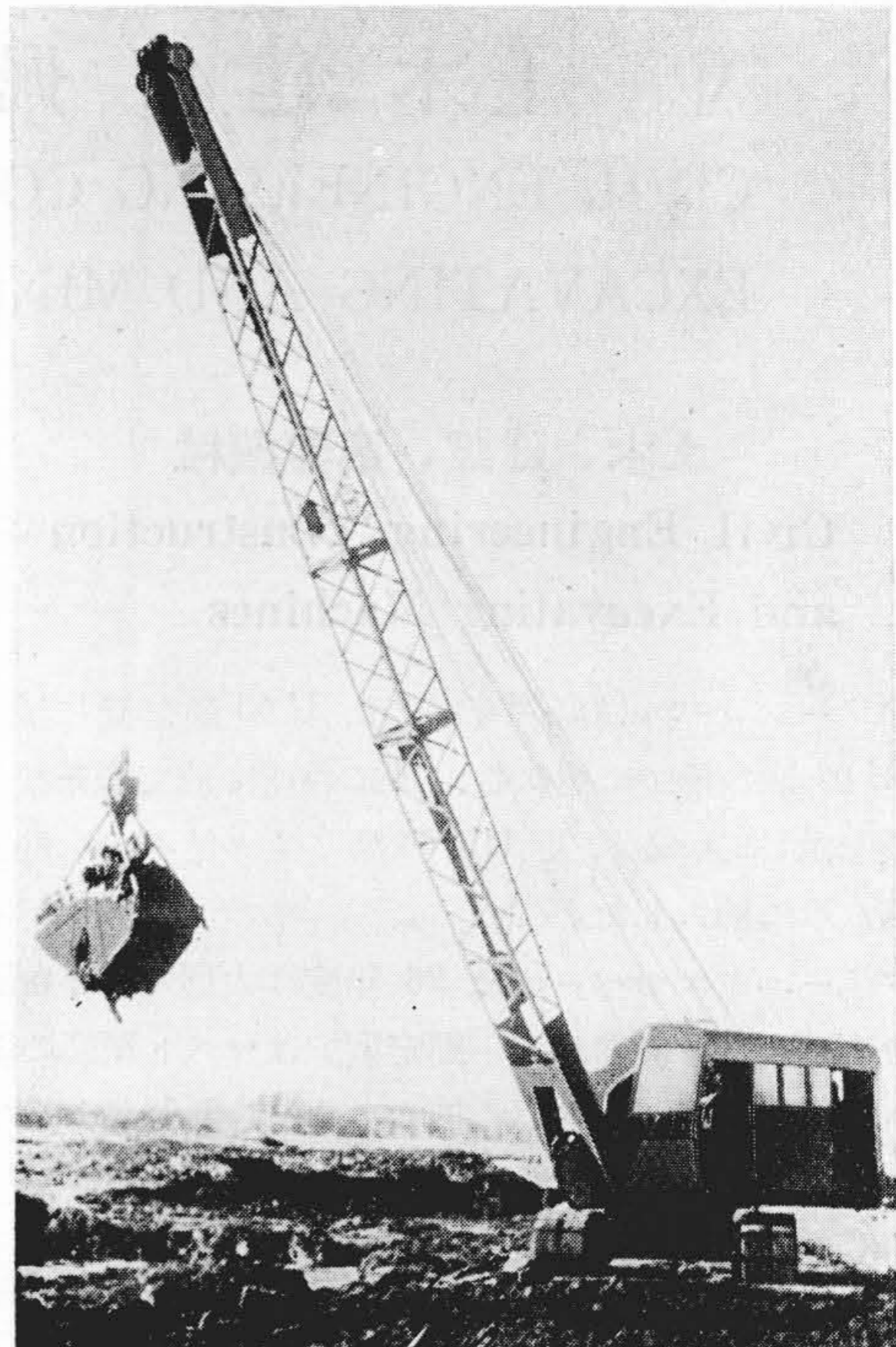
第 4 図 日立万能土掘機クラムシエル装架 UG 06 型
