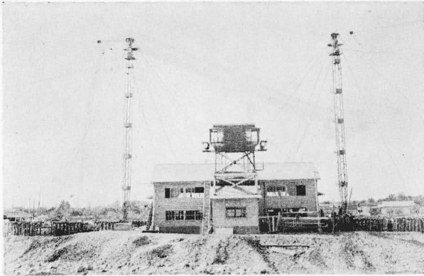
第 5 図 2 m 3 固定式タワーエクスキャベータ Fig. 5 2 m 3 Fixed Type Tower Excavator
