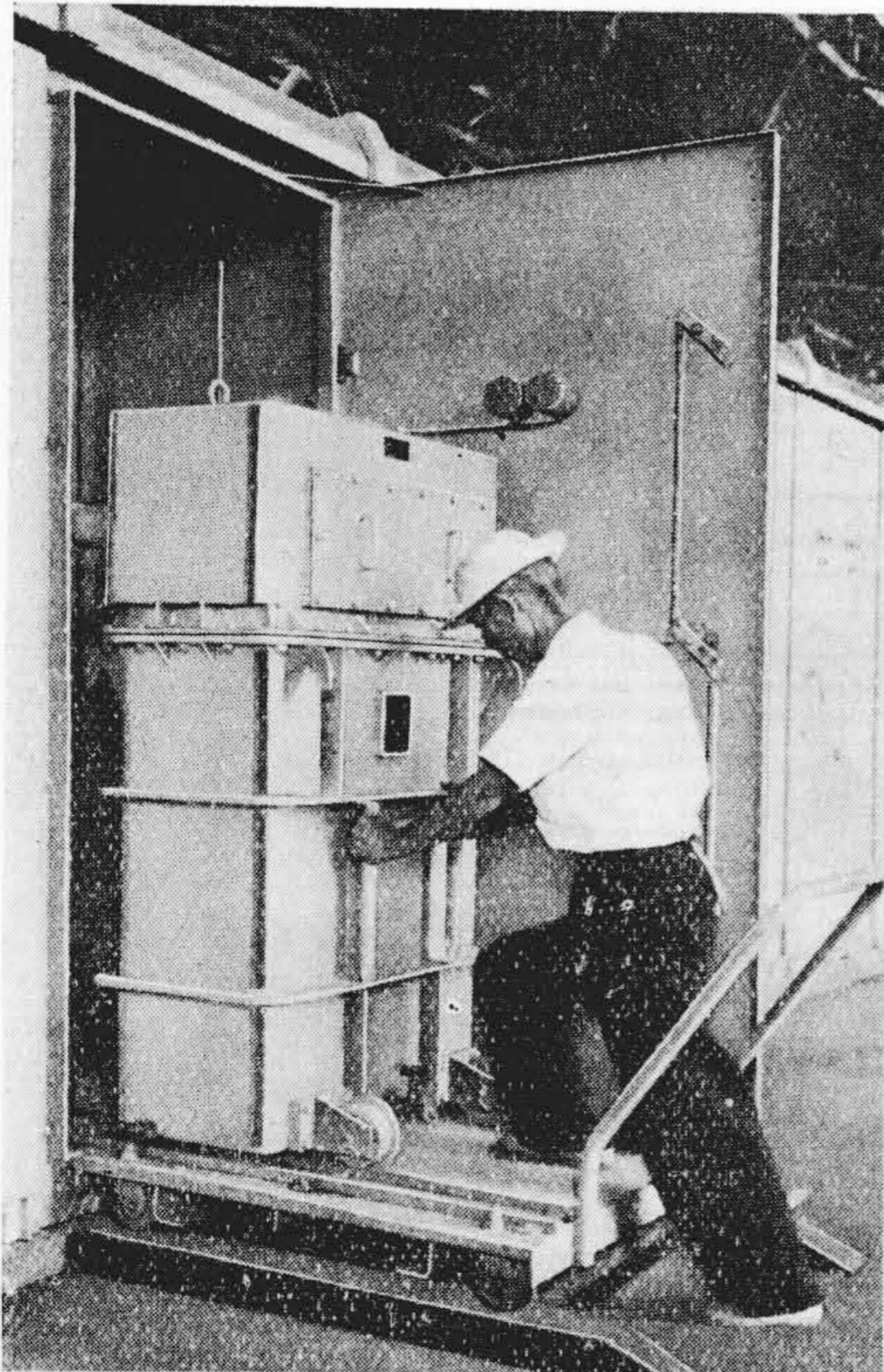
第15図 引出型電源変圧器 Fig. 15. Draw Out Type Service Transformer
