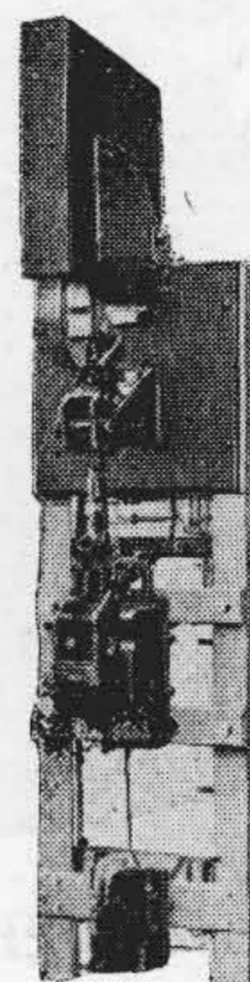
第47図 主回路用気中遮断器 Fig. 47. Air Circuit Breaker for Electric Winder
