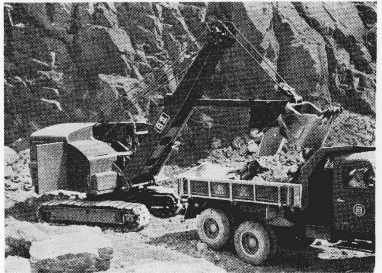
第1図 岐阜県丸山ダム工事場に於ける UL06 型ショベル
