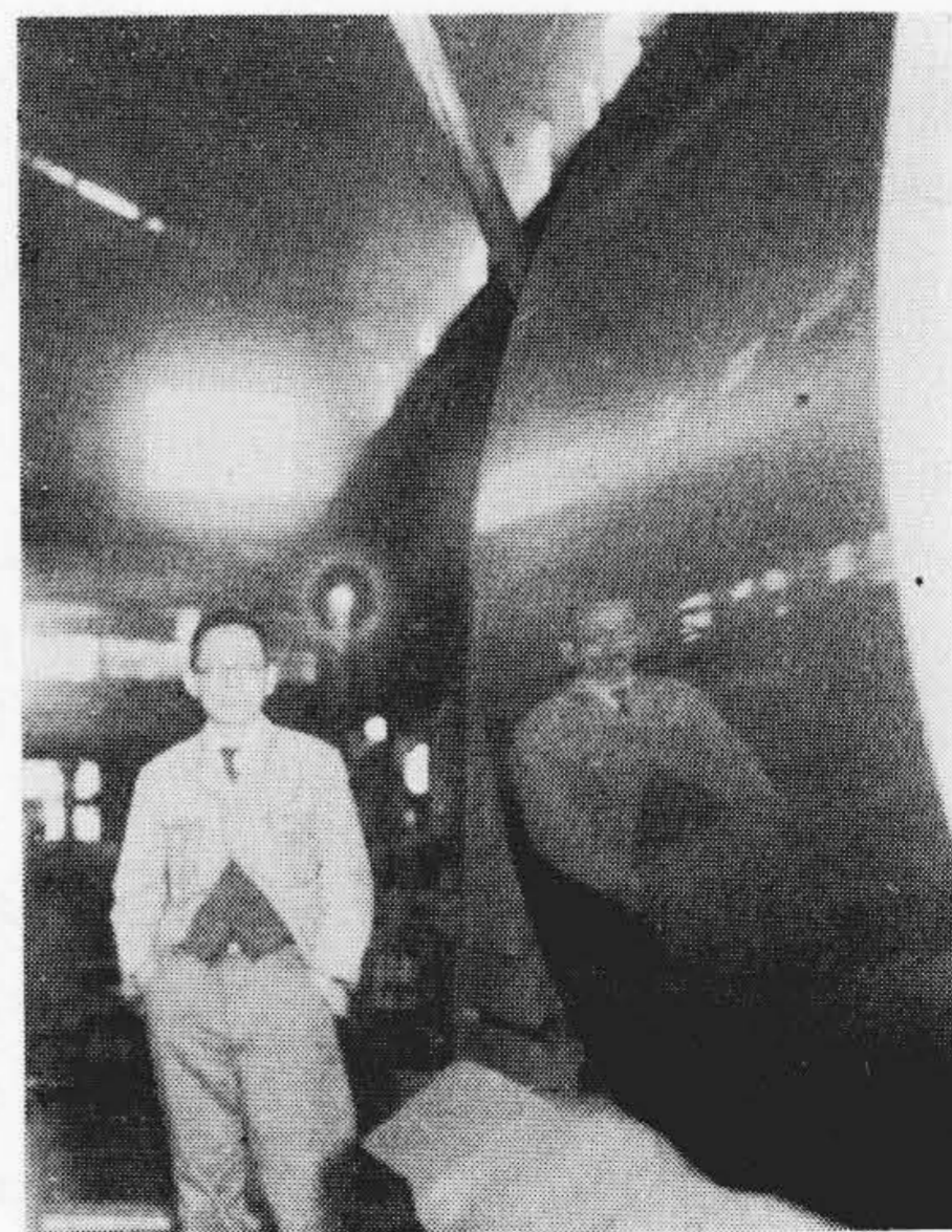
第8図 超仕上げしたヤンキードライヤ
