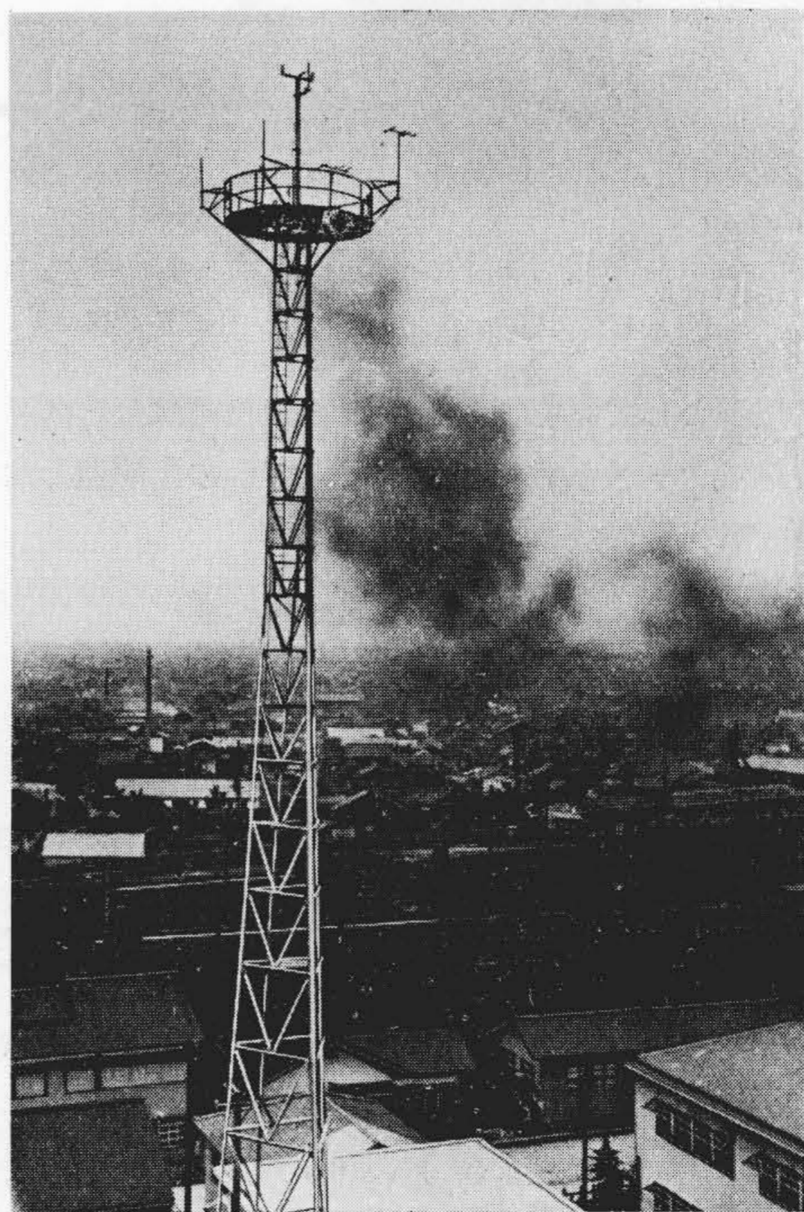
第60図 名古屋局空中線 (朝日新聞社提供) Fig. 60. Four Element "Yagi" at Nagoya (Photograph by the Courtesy of the Aasahi Press)
