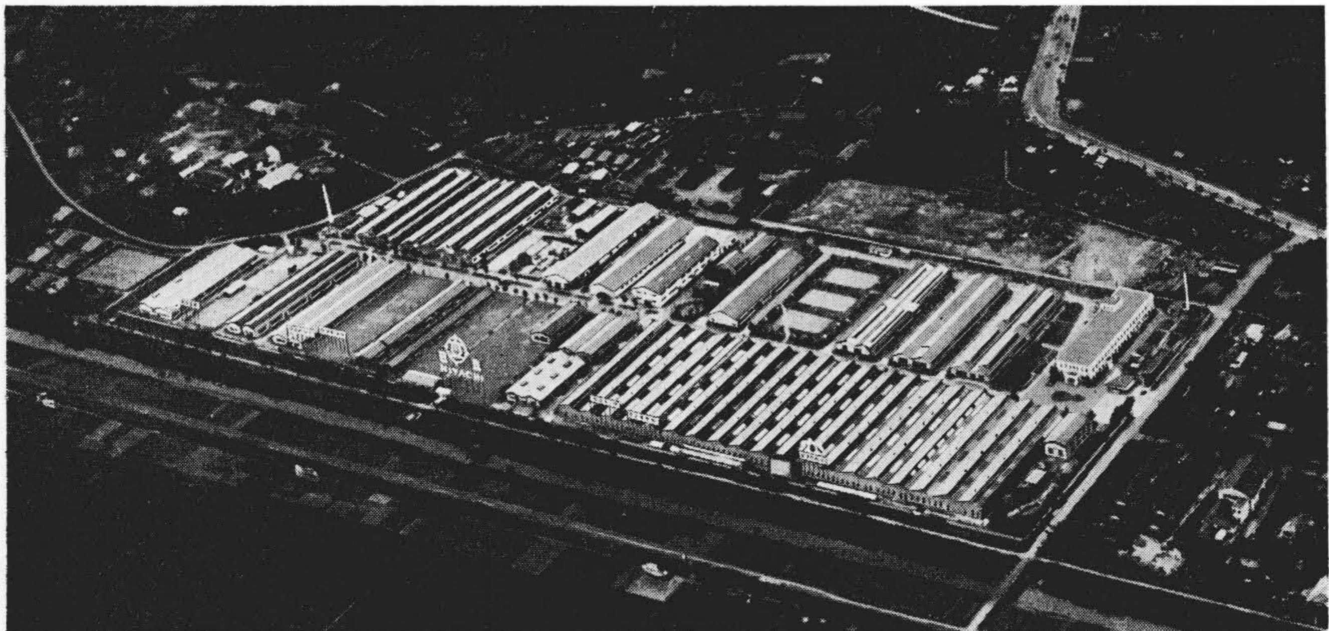
戸塚工場全景
