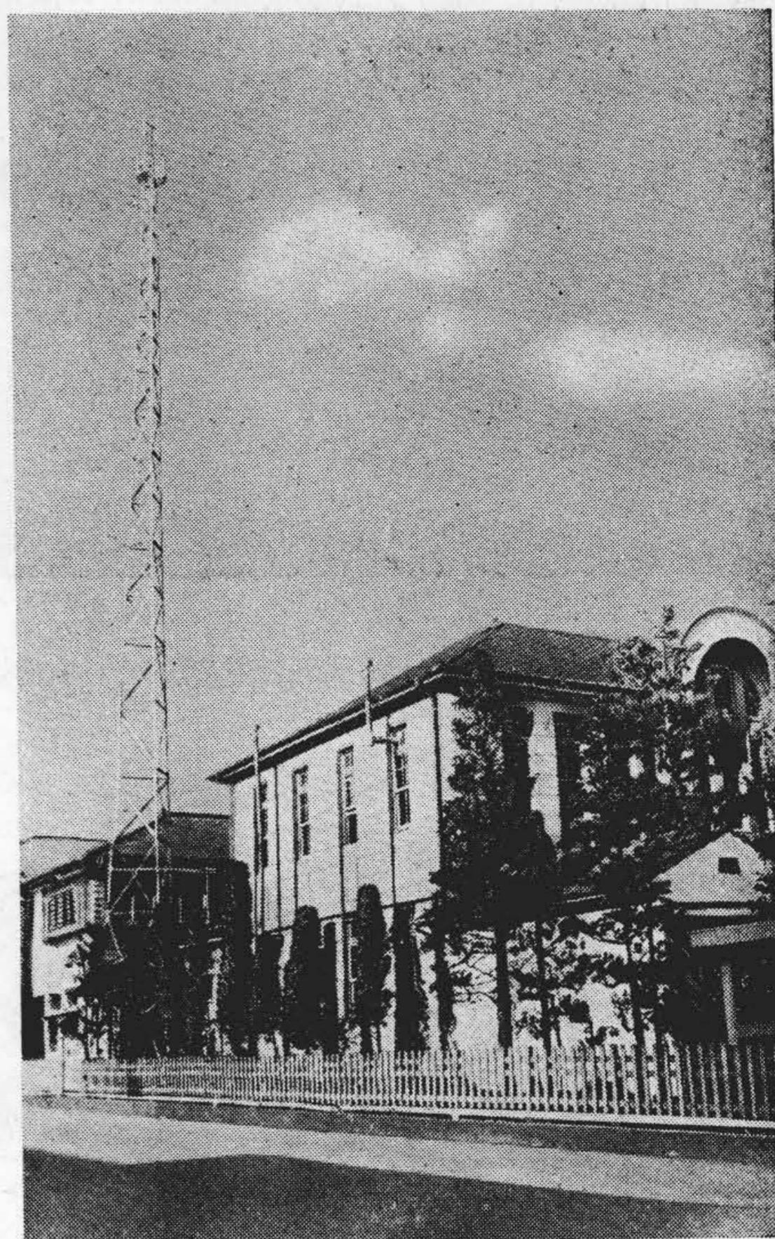
第53図 神奈川県庁小田原地方事務所空中線 Fig. 53. Antenna Installed at Fixed Station
