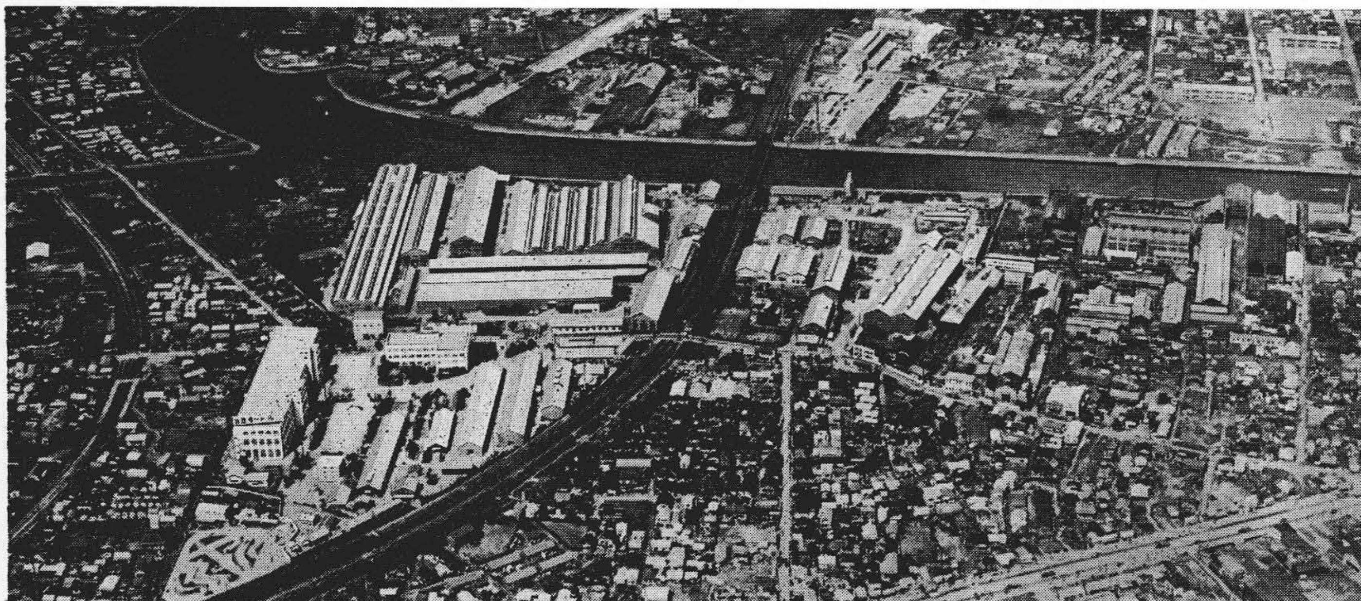
亀戸工場全景
