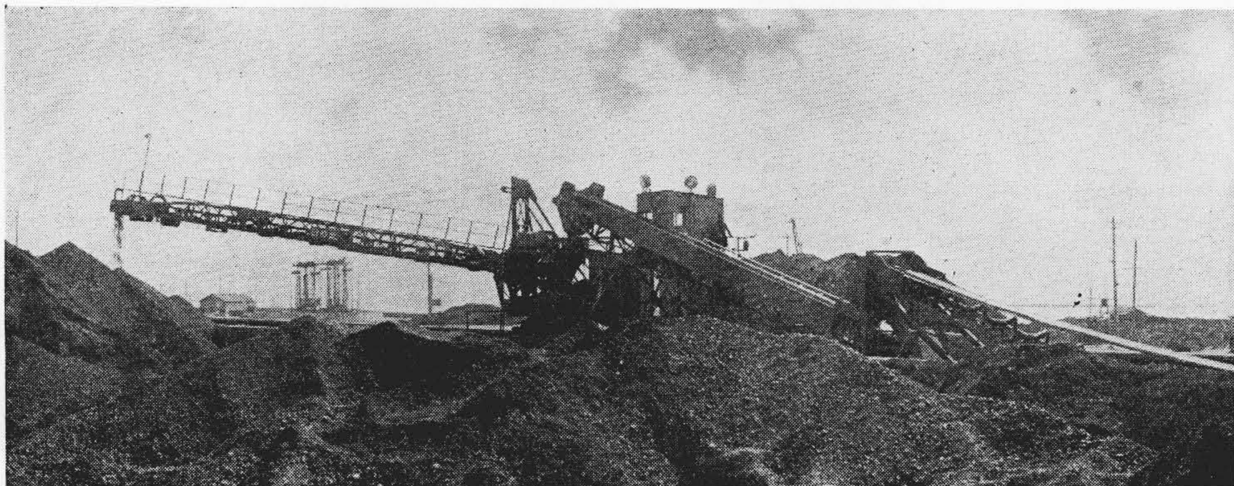
第 18 図 200 t/hr 鉱石用デイス تريビュータ
