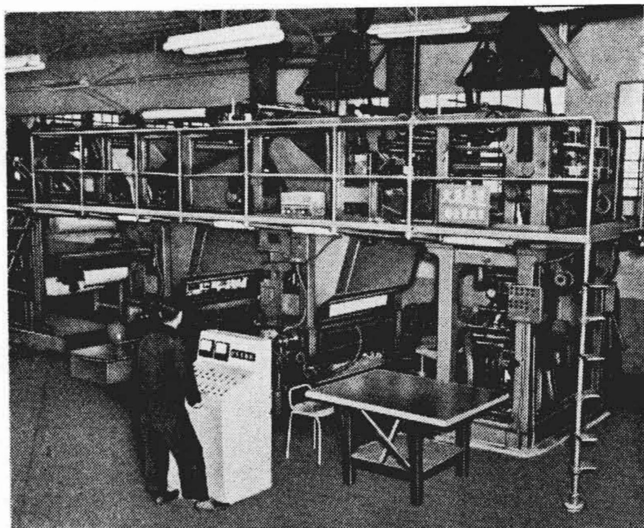
第12図 主操作盤にて運転中 Fig.12. Operation at Main Switchboard
