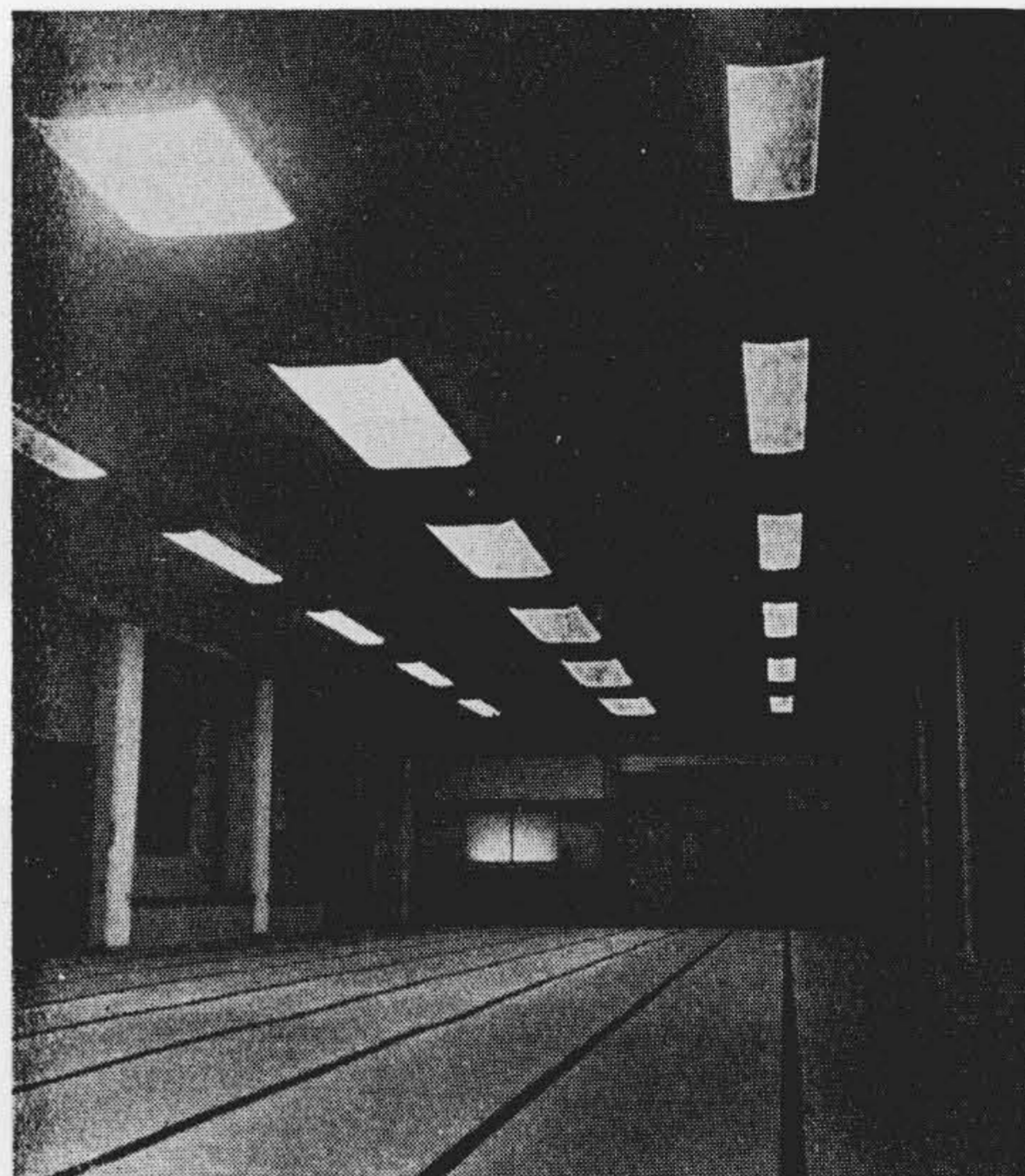
第 12 図 鬼怒川館の蛍光ランプ器具による照明 Fig.12. Fluorescent Lighting of Kinugawa Hotel
