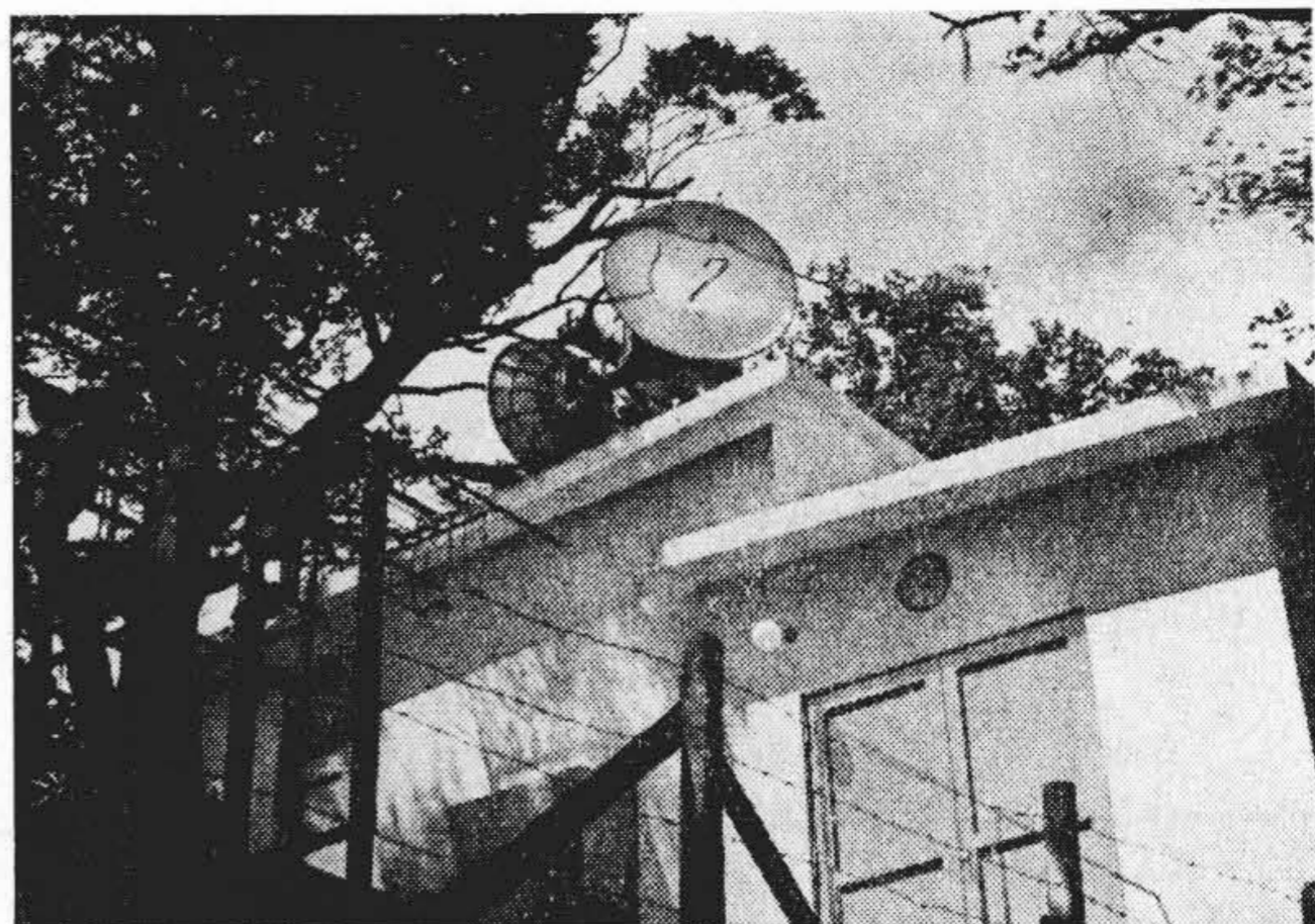
第5図 筑波中継局外観 Fig. 5. Tsukuba Repeating Station
