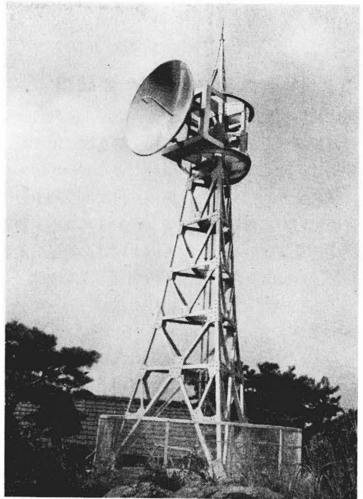
第11図 大夔中継局空中線鉄塔 Fig. 11. Parabolic Antenna and Antenna Tower at Ōmika Repeating Station
