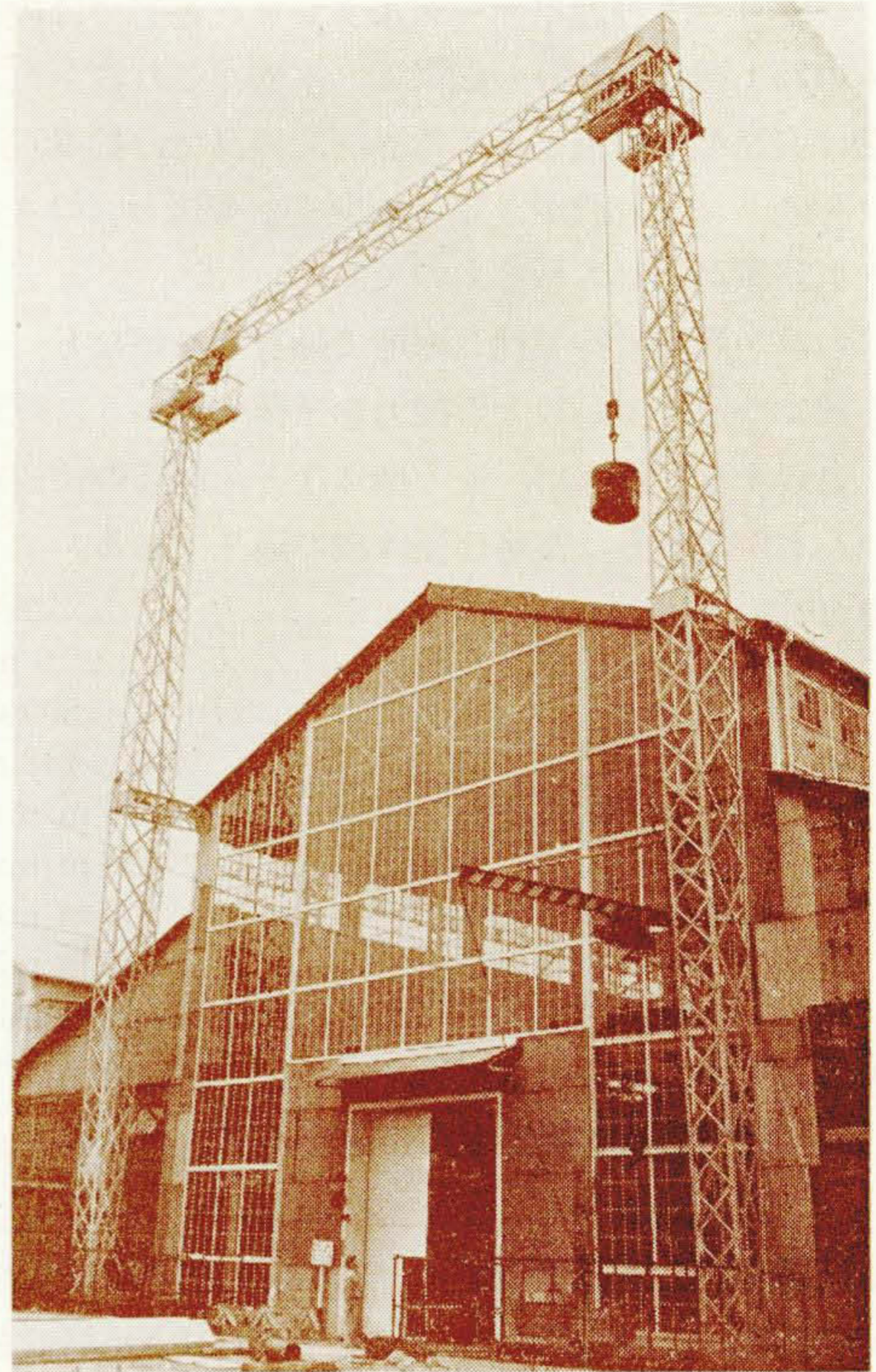
第12図 船用電動揚貨機試験塔
