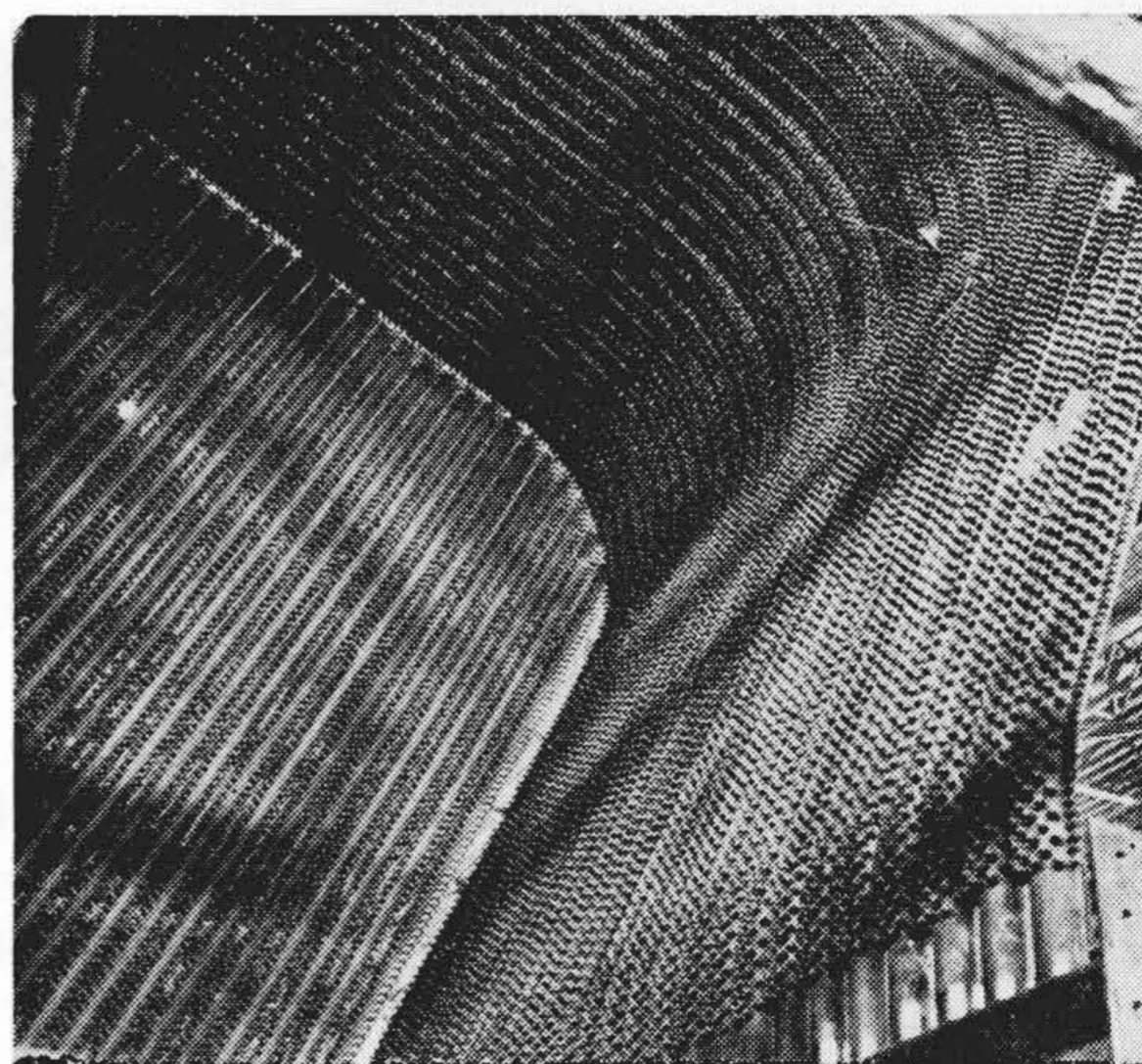
第8図 スタッド付水冷炉壁
