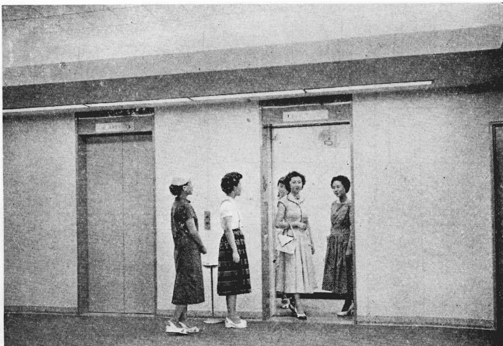
第22図 丸紅ビルで活躍中の全自動並列運転方式のエレベータ
