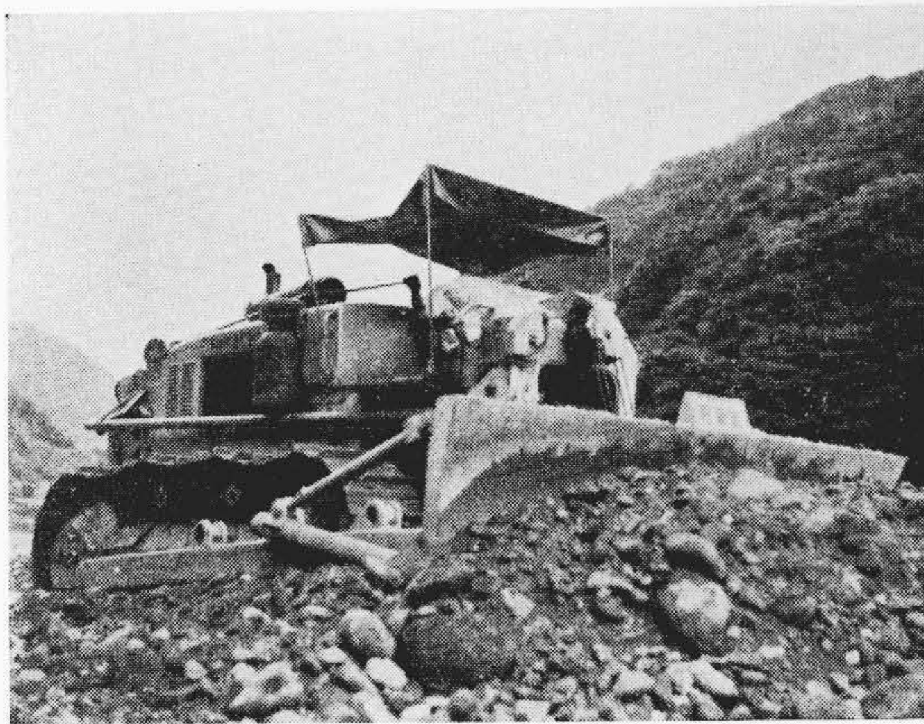
第4図 長野県濁沢川における河床掘削作業中の T14A アングルドーザ
