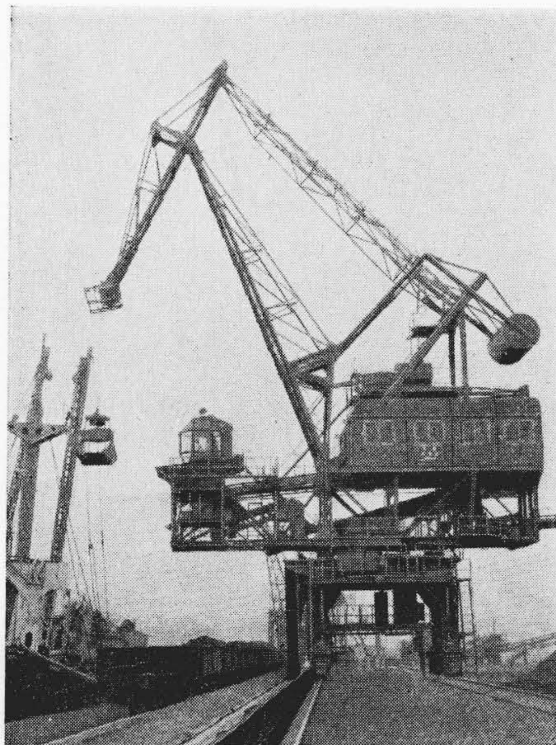
第 7 図 5 t 引込クレーン
