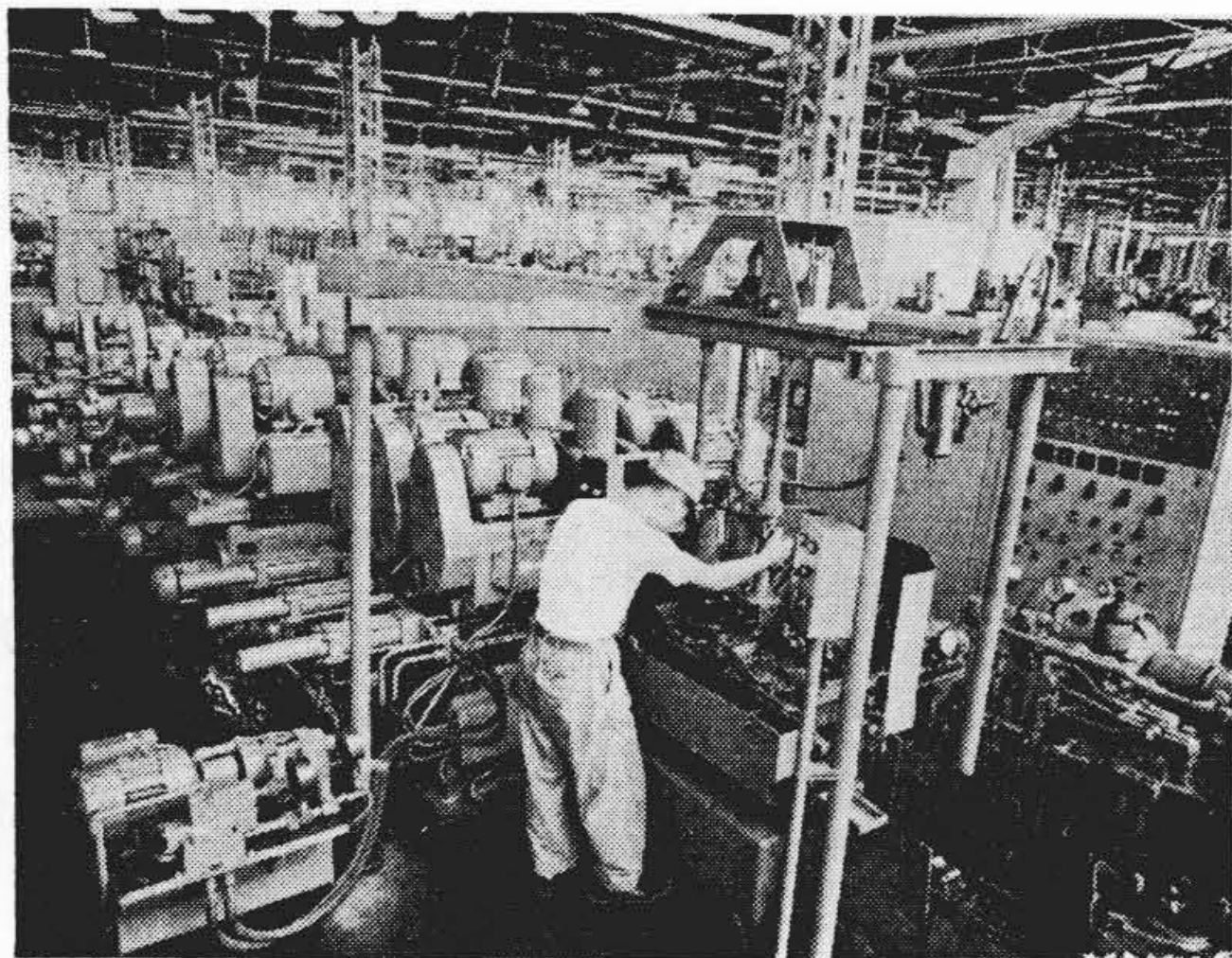
第9図 いすゞ自動車納 ユニバーサルジョイント・ヨーク用トランスファマシン
