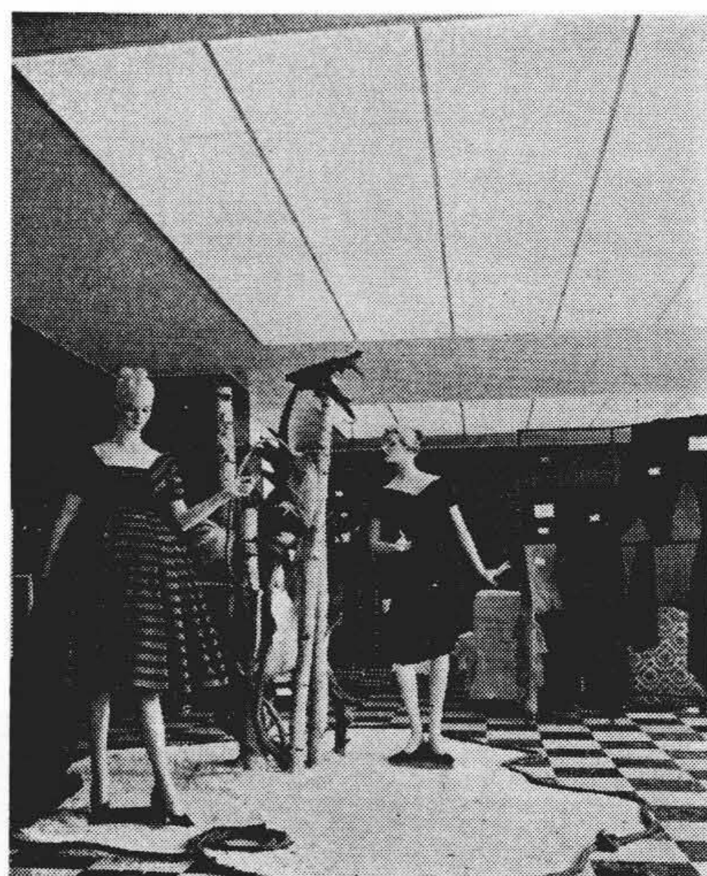
第21図 枠形ルミパネルによる陳列室（伊藤万ビル）の照明
