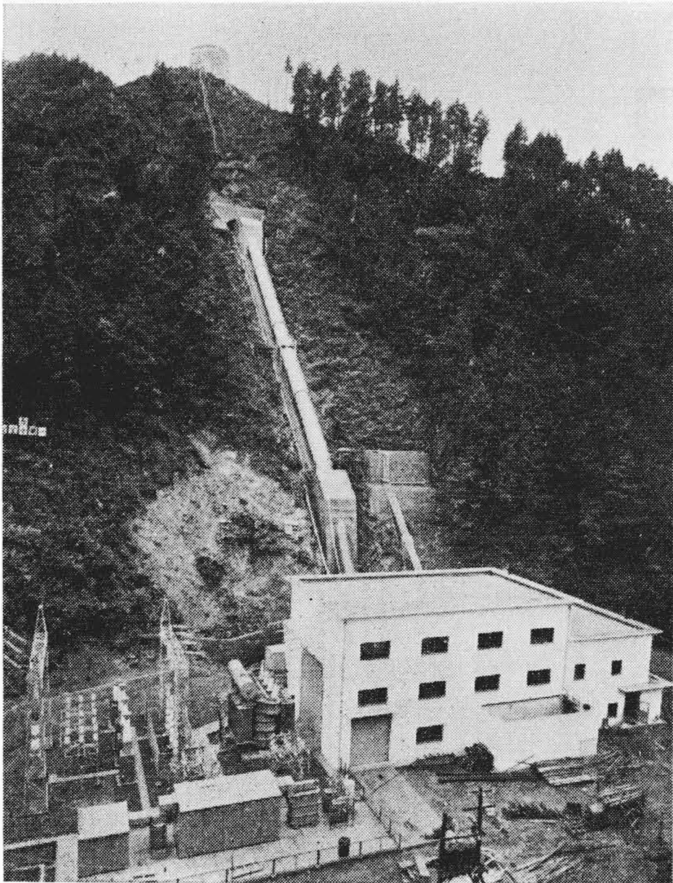
第22図 完成された発電所全景
