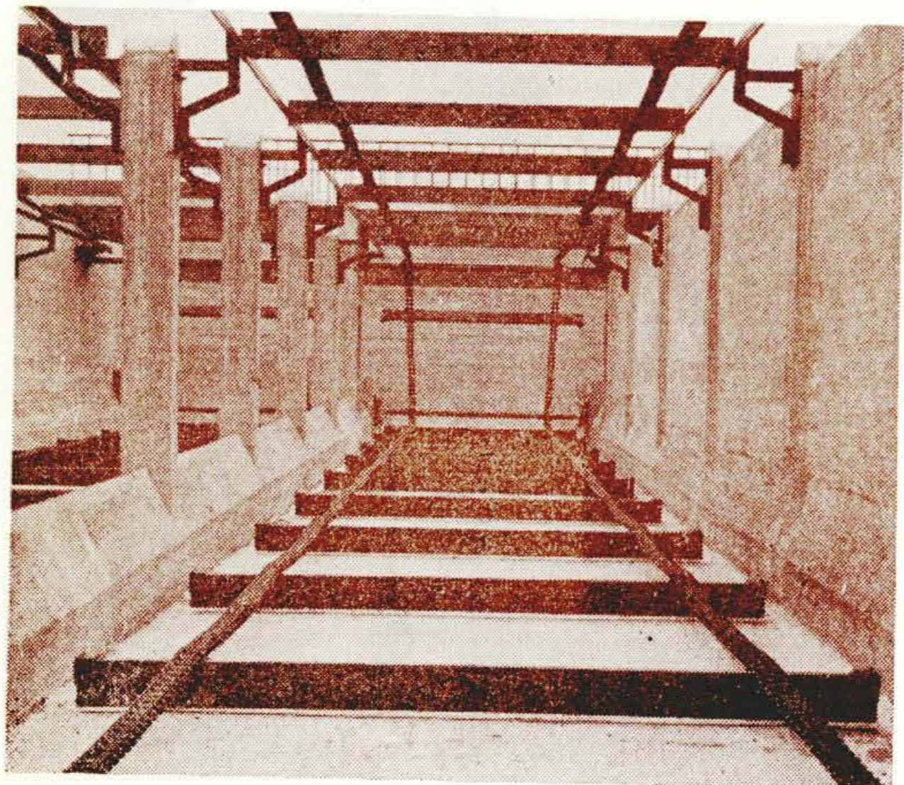
第 12 図 槽底部より見た汚泥コレクタ
