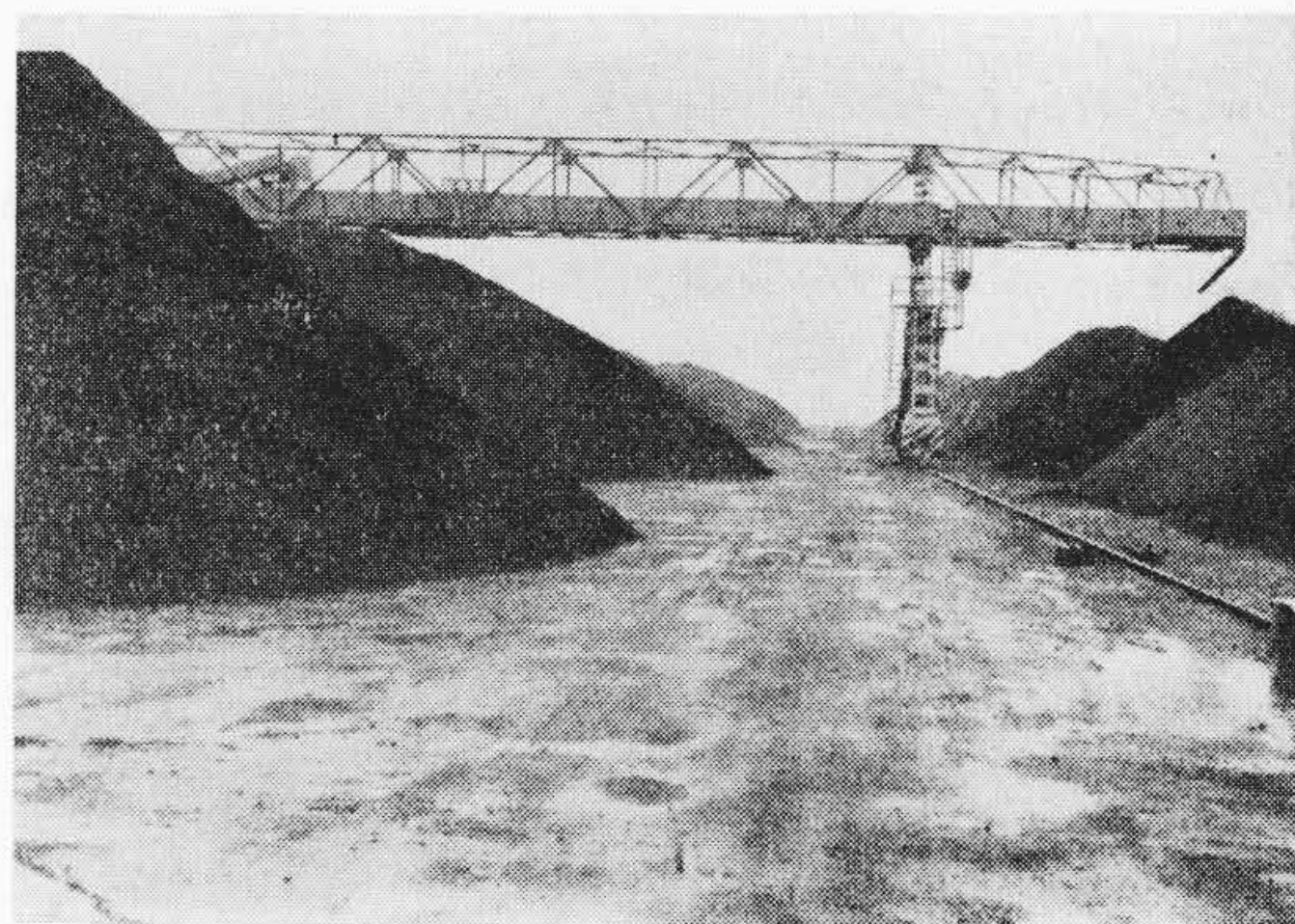
第9図 貯炭場における移動機械の通路
