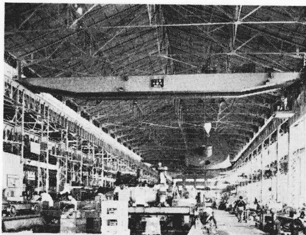
第5図 クラス2 天井クレーン
