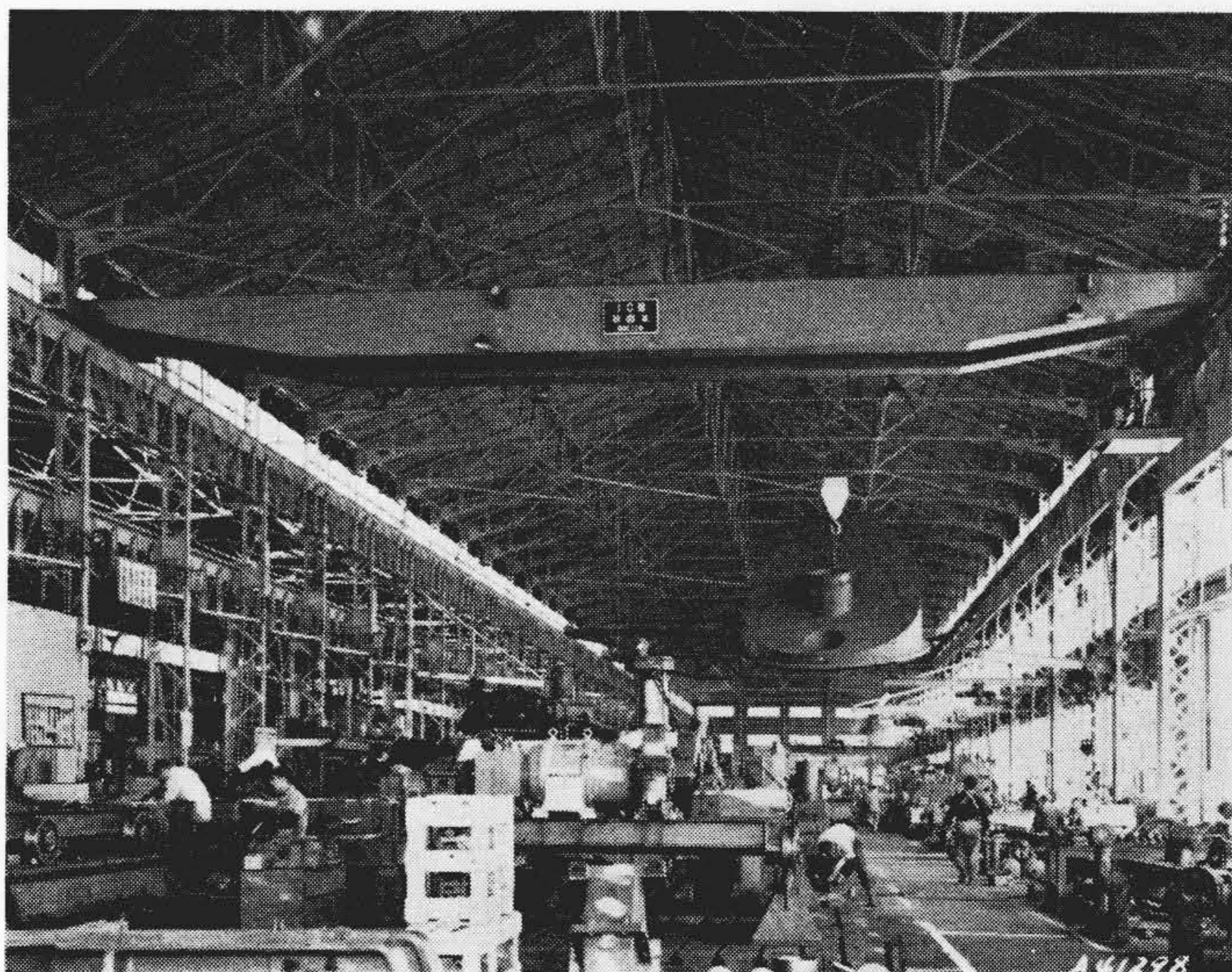
第6図 ボックスガーダを採用した天井クレーン
