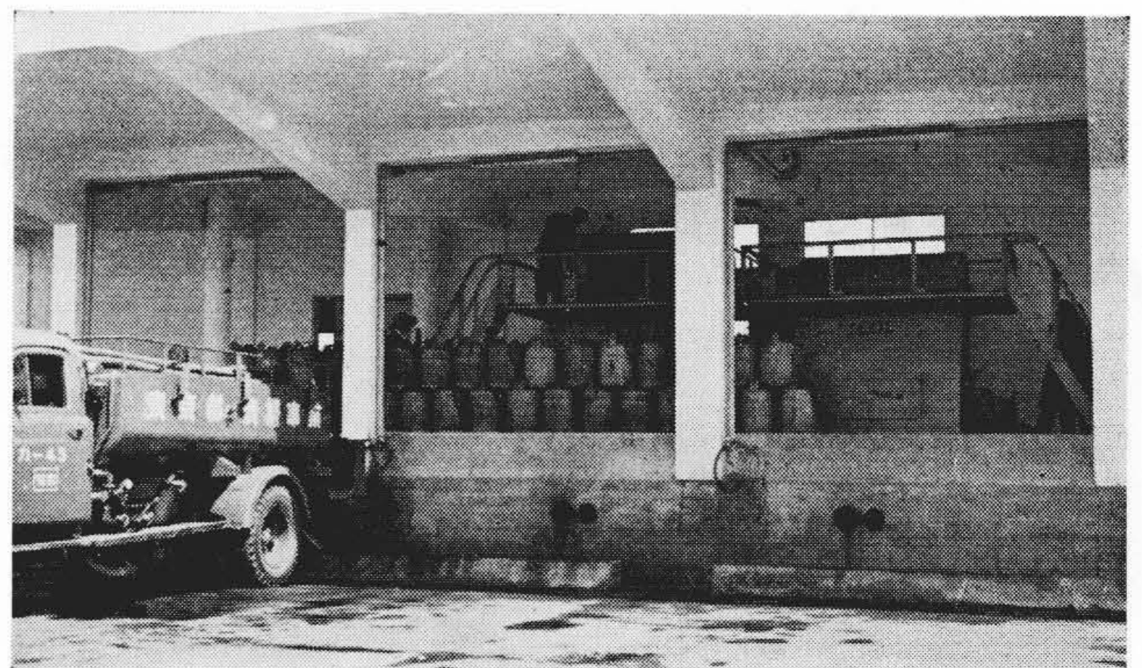
第32図 東京都清掃局東品川糞尿処分場納電動式バースクリーン
