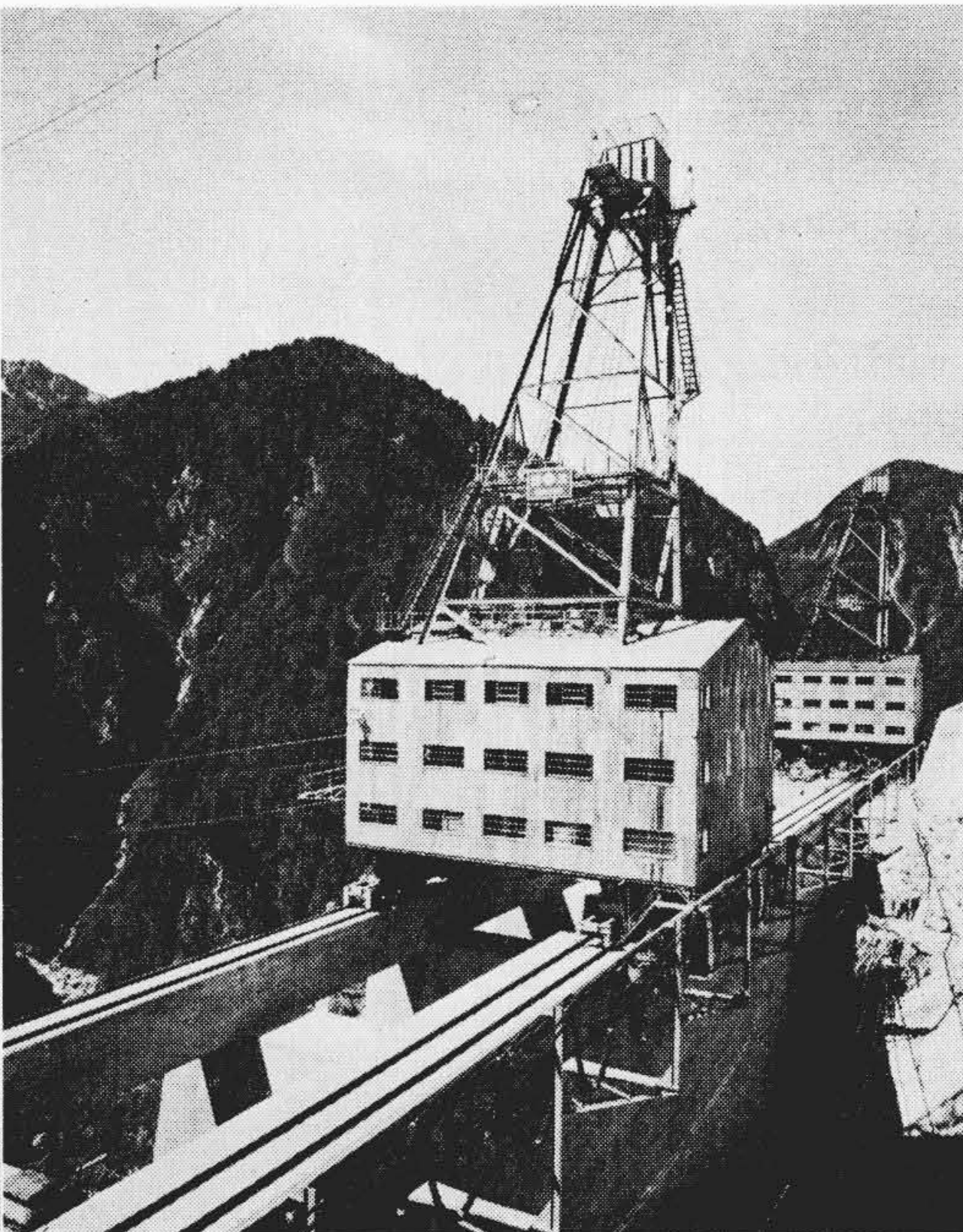
第14図 25 t ケーブルクレーンエンジンタワー
