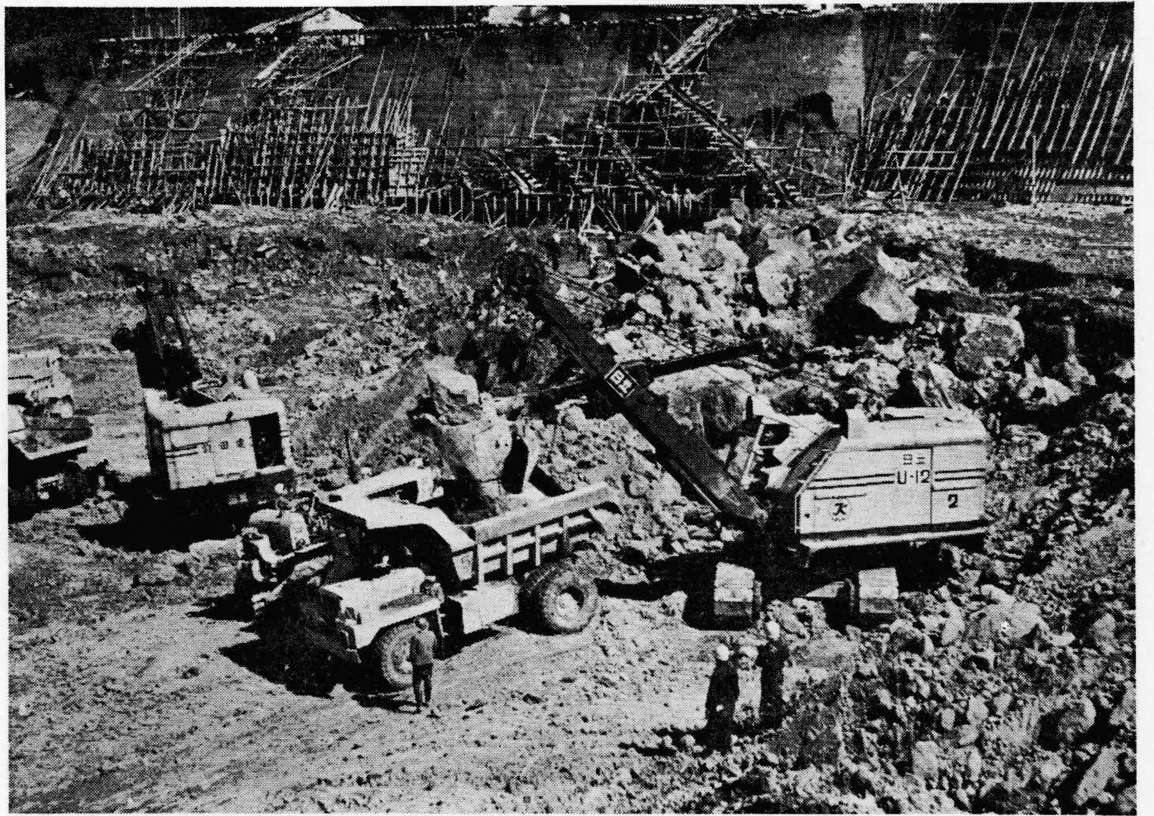
第1図 掘削作業中のパワーショベル
