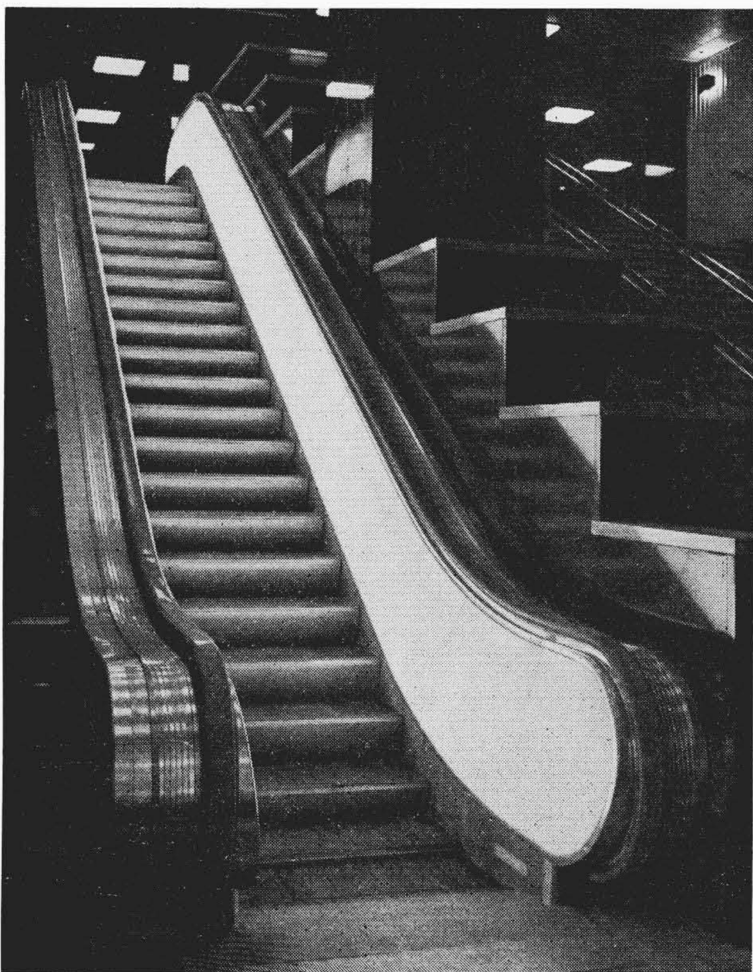
第10図 新朝日ビル 1200 T-L エスカレーター
