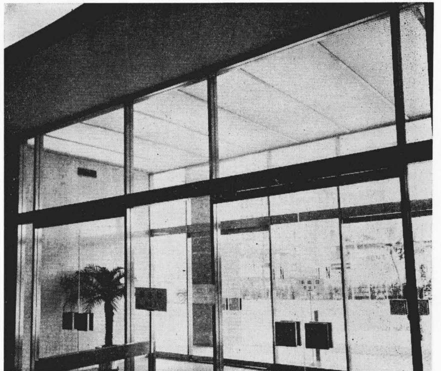
第12図 エンドレスルミパネルを使用した光天井によるビル入口の緩和照明
