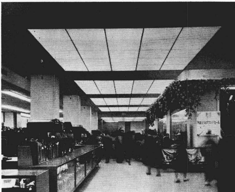
第19図 わく形ルミパネルを多数使用した光天井による
