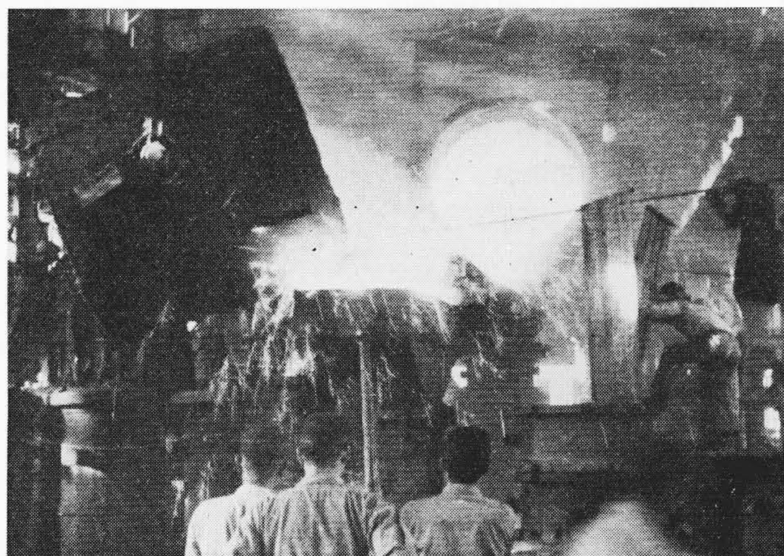
第21図 ボトムロールの鑄込状況
