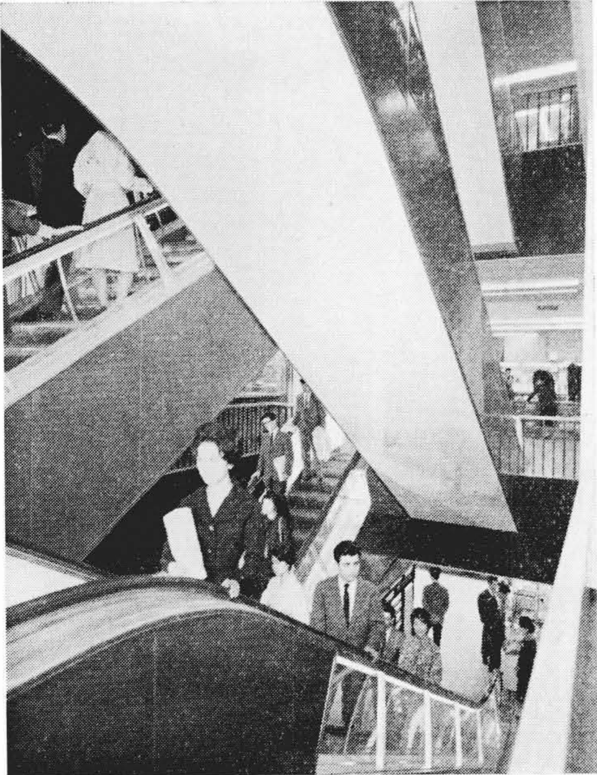
第11図 横浜高島屋納複列交差設置 透明式エスカレーター
