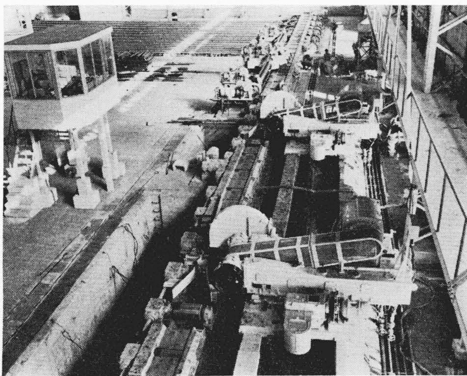
第8図 ホットソーおよび定寸機
