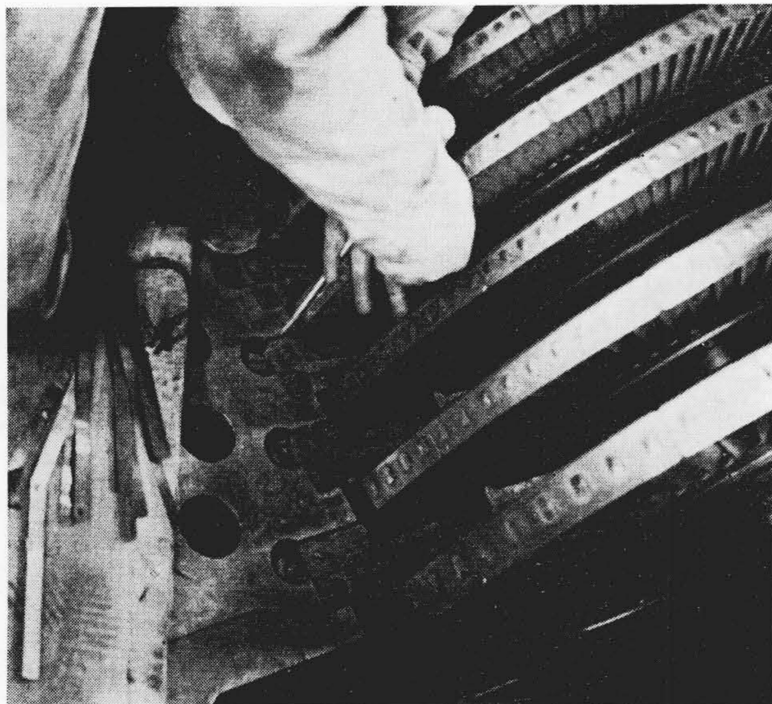
第6図 翼車間げきの計測
