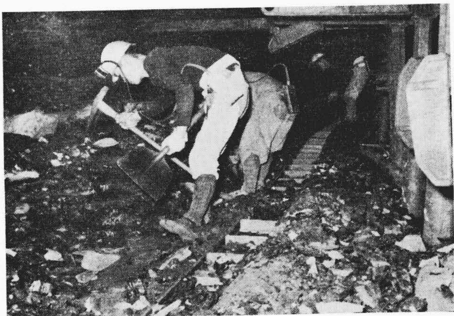
第 7 図 坑内にて稼働中の L 形チェンコンベヤ
