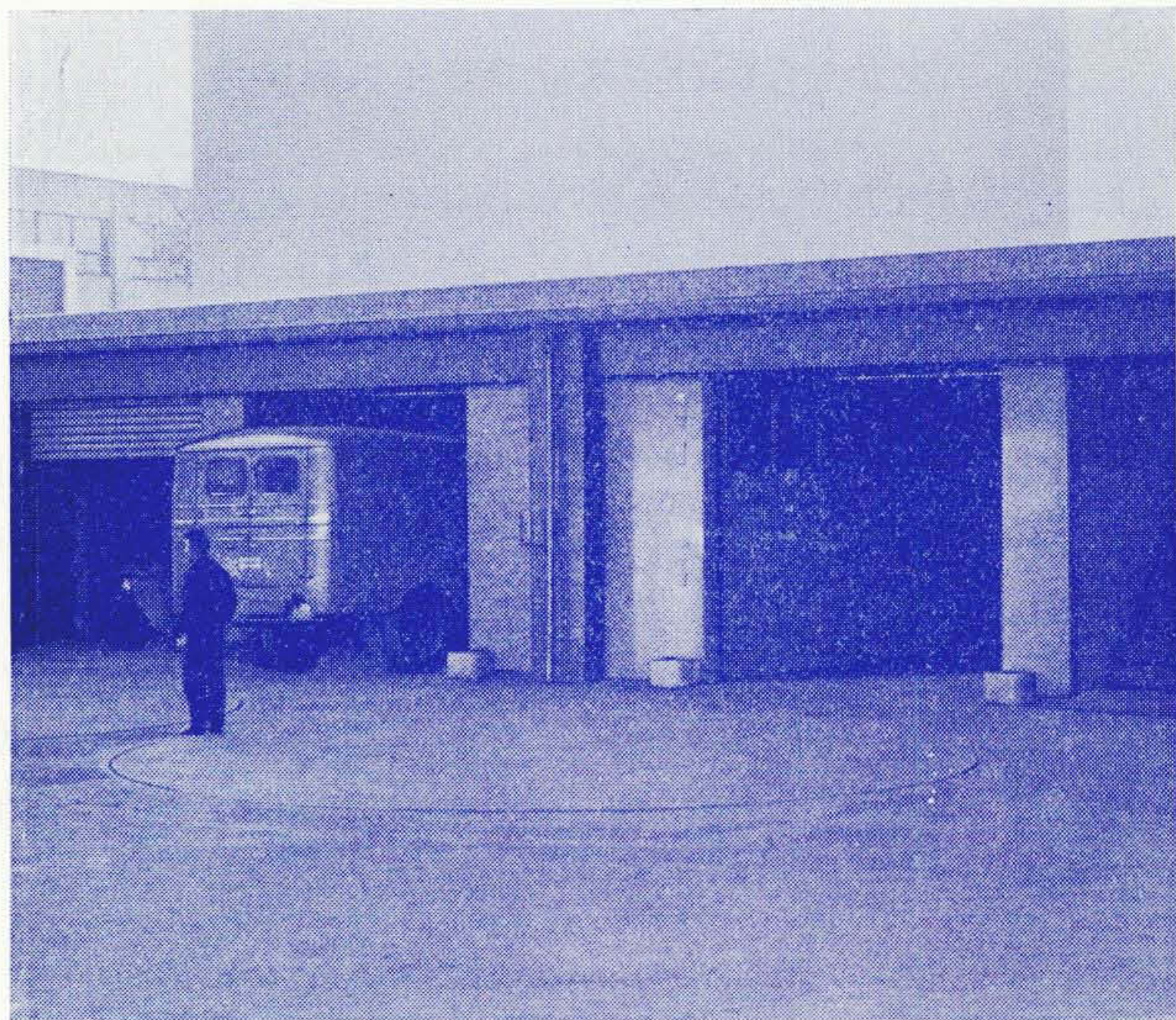
第10図 京都中央郵便局納自動車用エレベータと ターンテーブル
