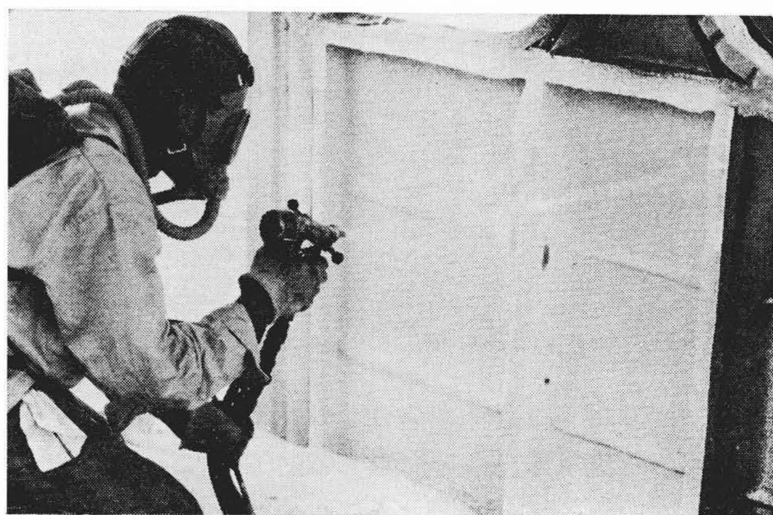
第9図 模型鋼体への吹付状況
