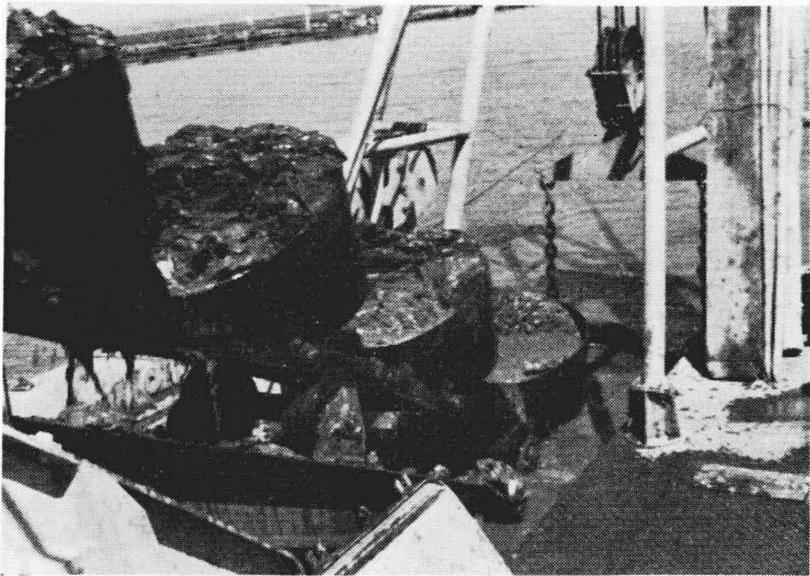
第 20 図 バケット・ポンプコンバインド浚せつ装置用バケットの揚泥状況
