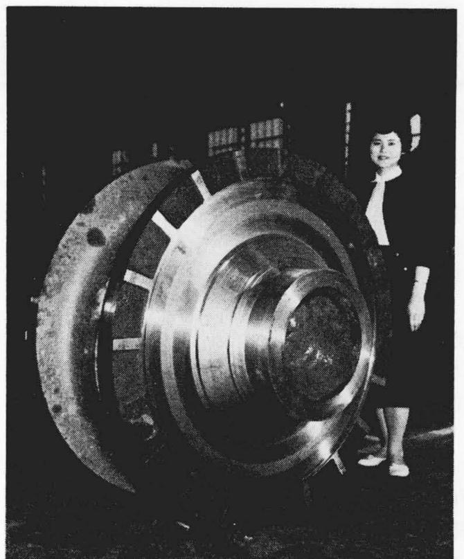
第18図 400mm 600HP ブレードレスサンドポンプ用羽根車
